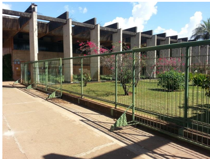
Figura 17 – Grades de proteção nos acessos ao edifício do ICC. Canteiro S1C
