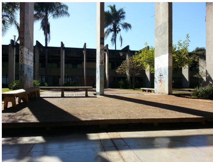
Figura 14 – Desnível para acessar as vias sobre a laje. Canteiro (C6A/C5A)
