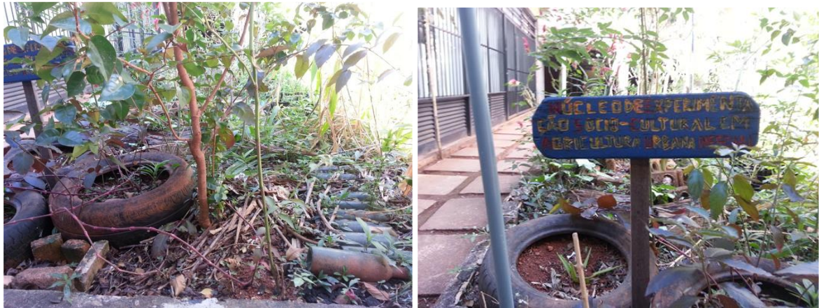
Figuras 63 e 64 – Falta de manutenção e cuidados no jardim do subsolo. Canteiro N7S
