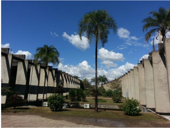
Figura 9 – Acesso entre blocos no nível do jardim. Canteiro C4C
