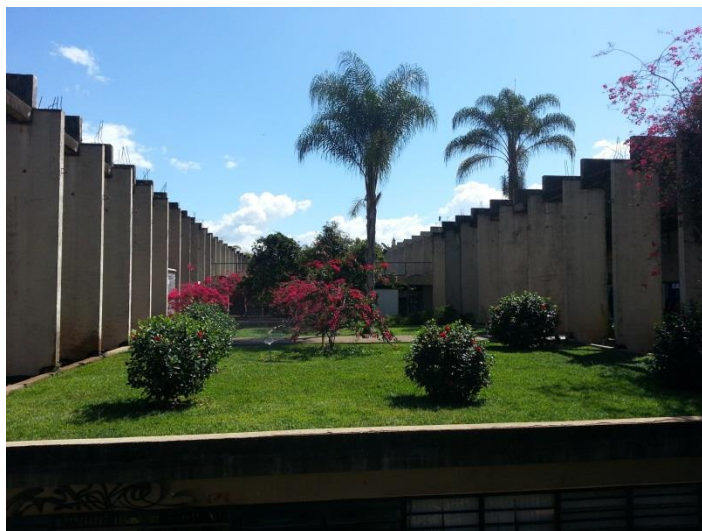
Figura 5 – Jardim sobre Laje. Canteiro S7C
