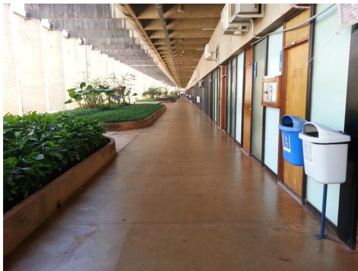
Figura 18 – Distribuição das lixeiras no ICC.
