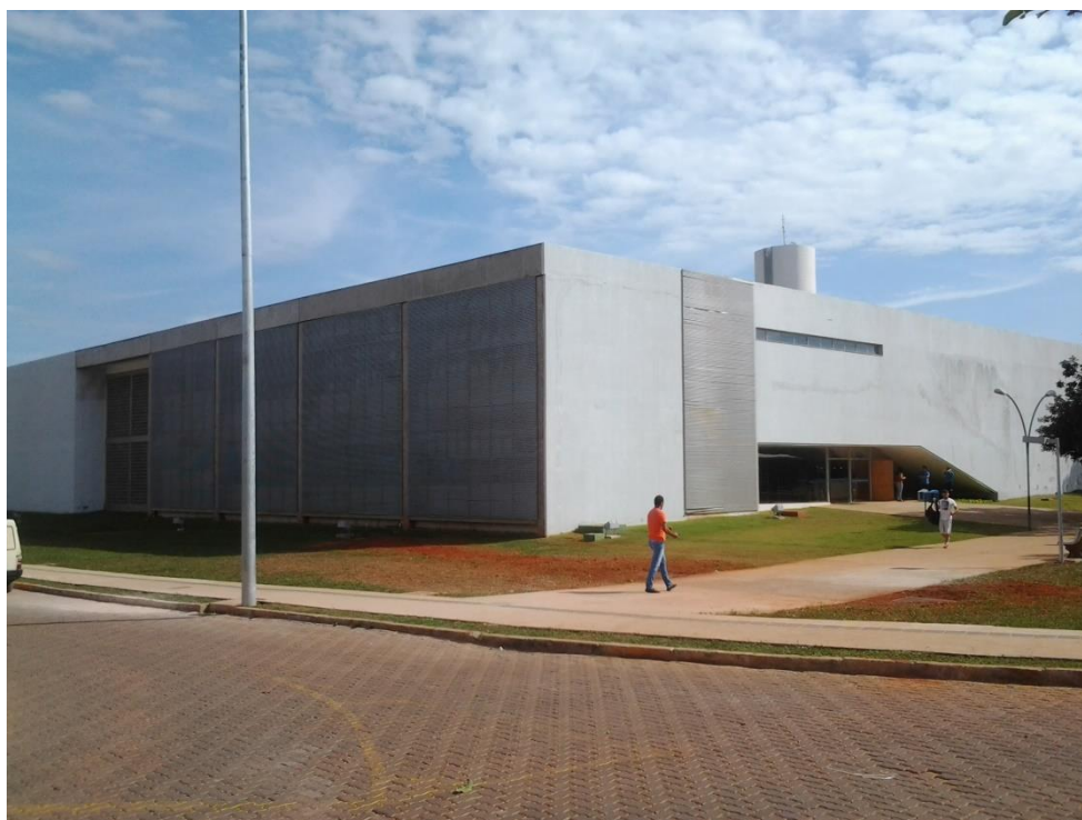
Figura 07 - Fachada de entrada do prédio UAC. Acervo do autor.
