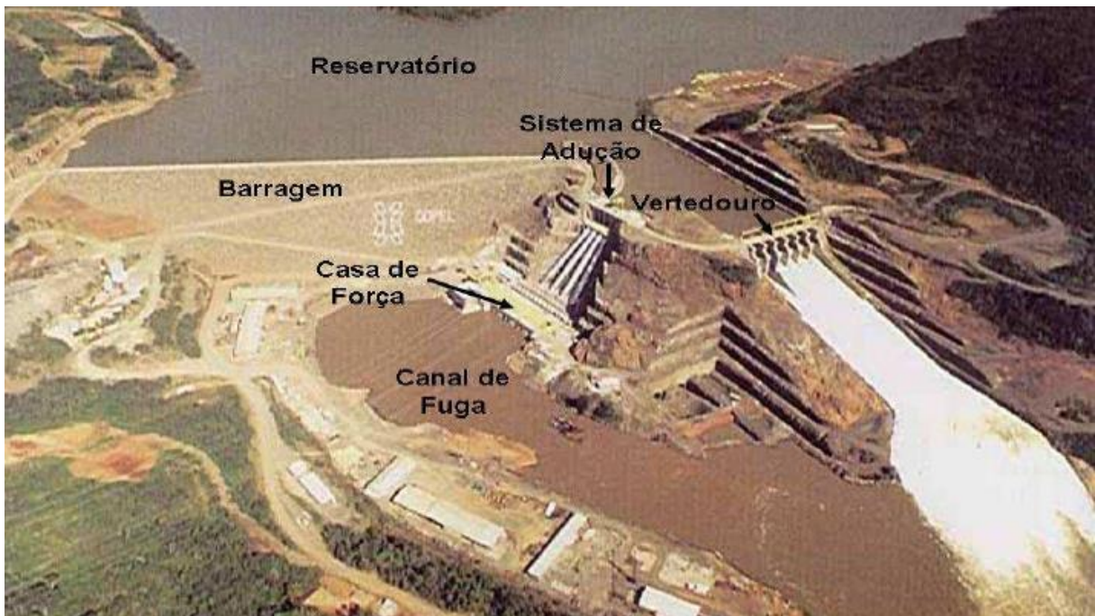
Figura 1. Usina Hidrelétrica (UHE). Fonte: (GUIMARÃES, 2007).
