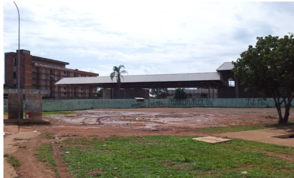
Figura 26: Obras de construção de edificações. Fonte: Acervo pessoal.
