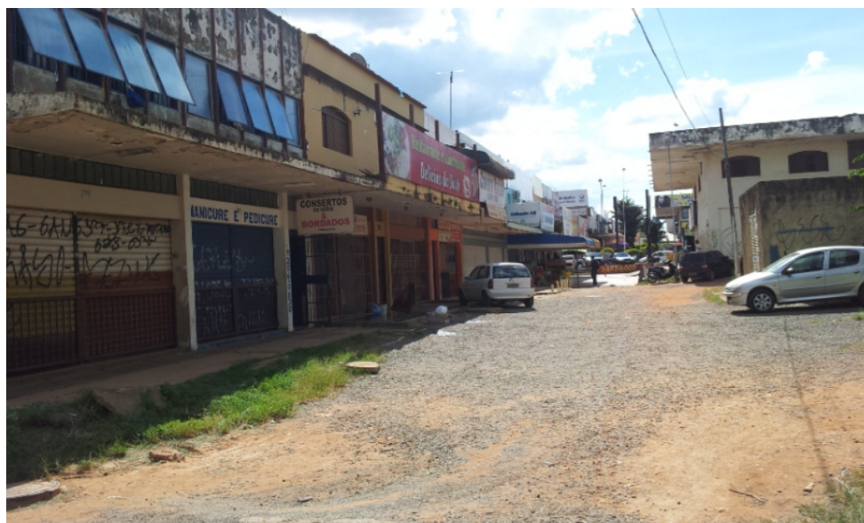
Figura 31: Estado de conservação em edifício particular. Fonte: Acervo pessoal.
