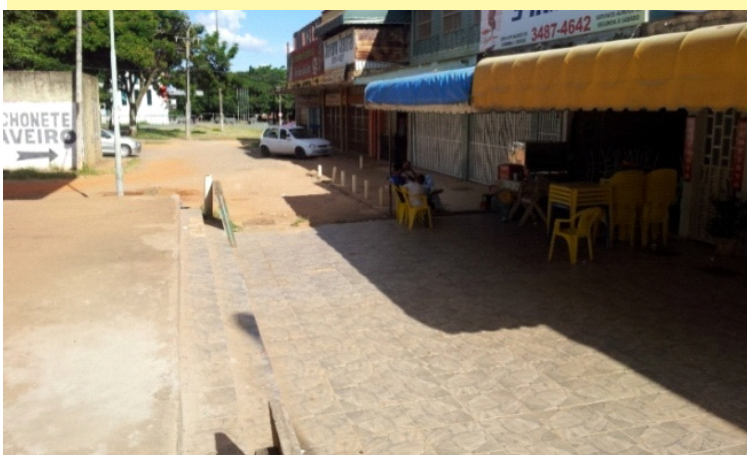
Excesso de desníveis
