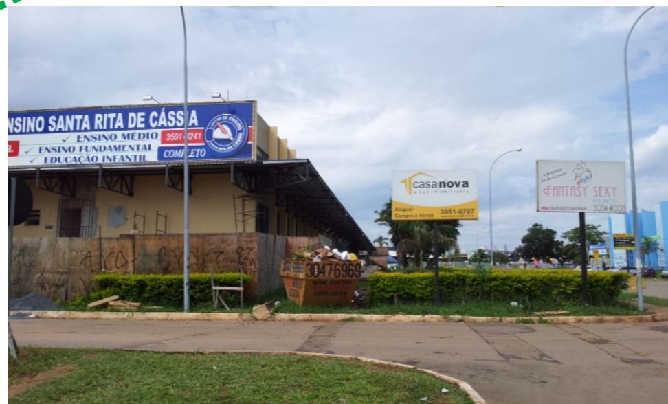
Figura 32: Obra de reforma em edificação. Fonte: Acervo pessoal.
