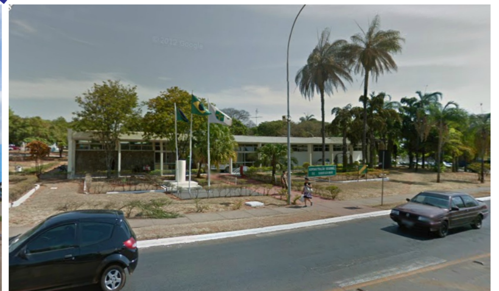
Figura 33: Estado de conservação em edifício público. Fonte: Google maps.
