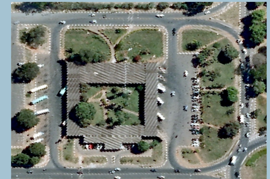
Figura 71: Calçada e área verde. Fonte: Google maps.
