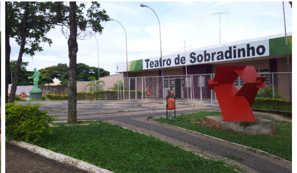
Figura 27: Estado de conservação em edifício público. Fonte: Acervo pessoal.
