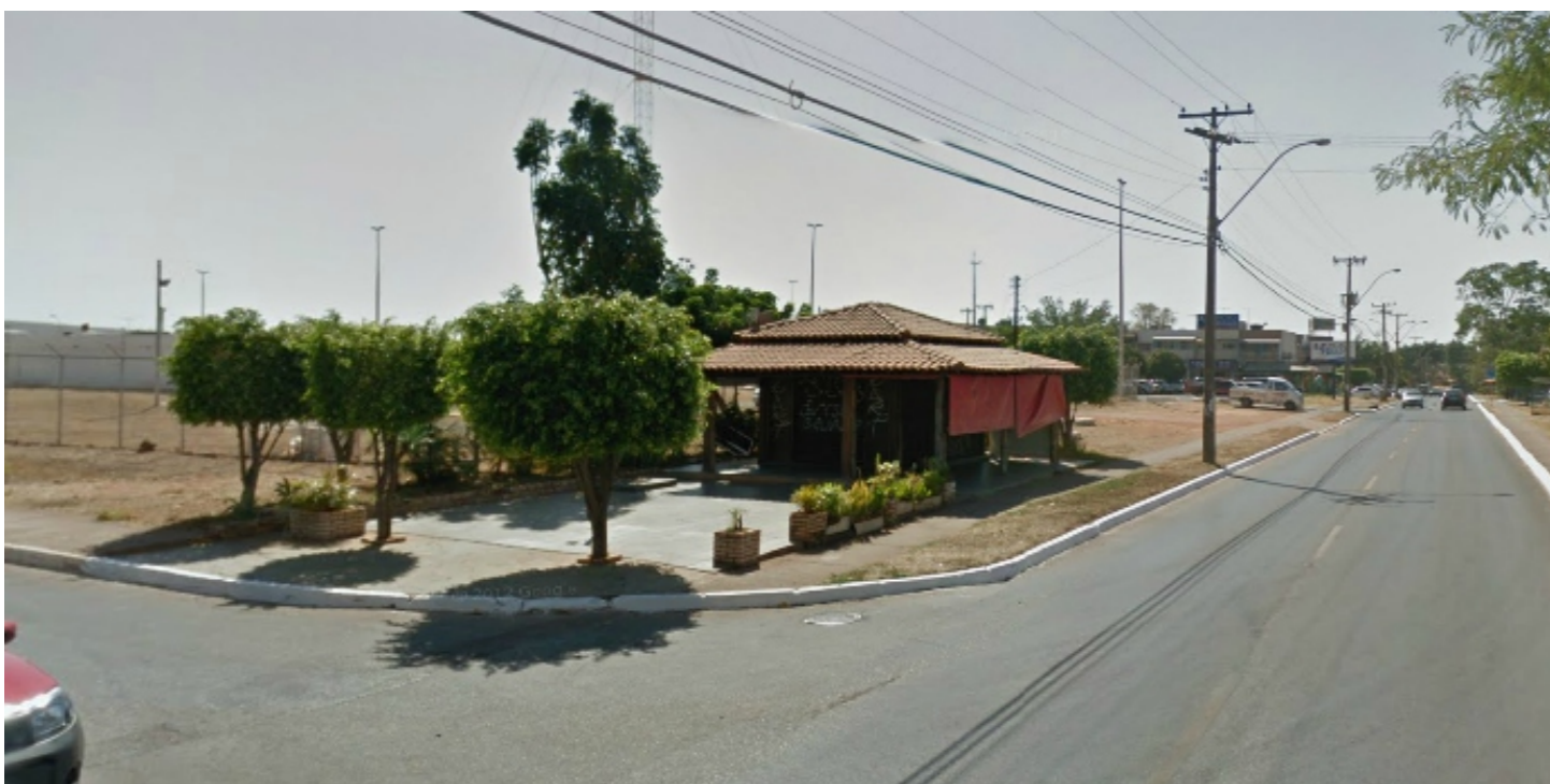
Figura 63: Lanchonete ao lado da CAESB e edificações multifamiliares. Fonte: Google maps.
