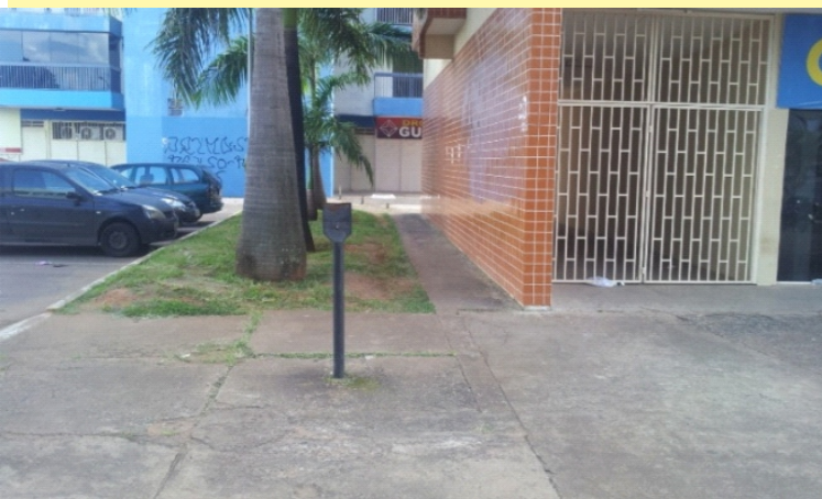
Estreitamento da calçada
