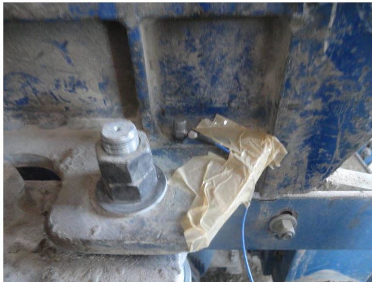
Figura 66 – Acelerômetro piezoelétrico preso à aba da forma.
