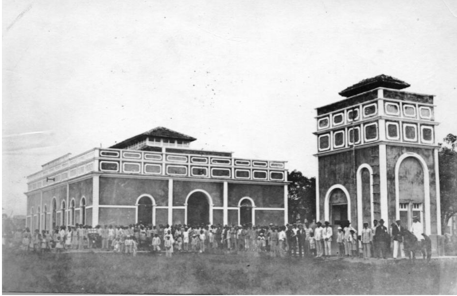
Foto 1 - Mercado Municipal. Inaugurado em 15/06/1929, no segundo aniversário de administração de Hugo Carneiro. Fonte: Relatório Hugo Carneiro. Museu da Borracha
