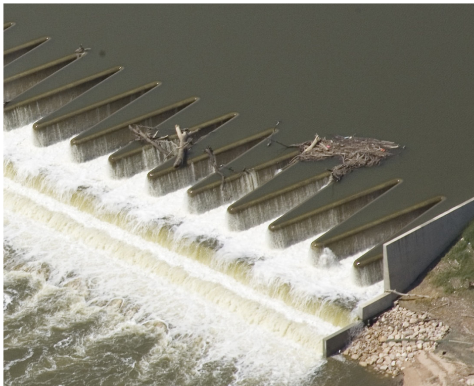
Fig. 1-1. Brazos Dam, Texas, USA
