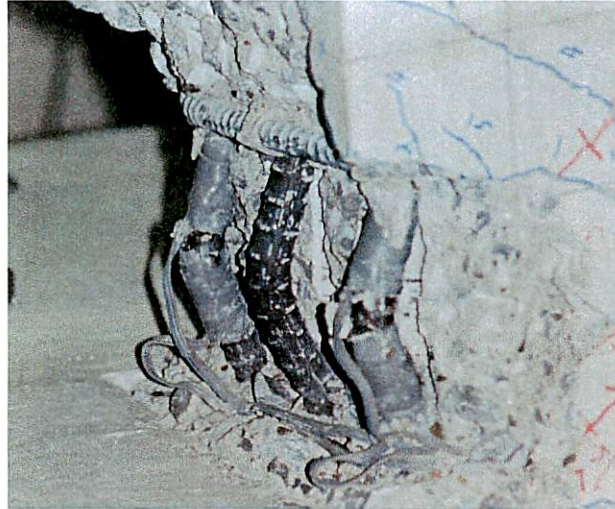
写真 3.16 鉄筋の座屈 (B13N10C)
