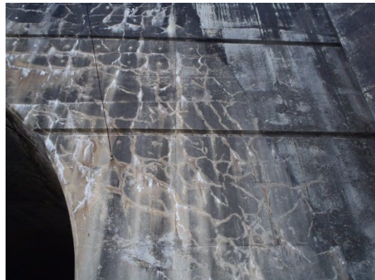
(e) トンネル E 坑門 (旧能都町産-安山岩砕石 D) ASR の判定：亀甲状ひび割れ (f) トンネル F 坑門 (手取川産-川砂利 A) ASR の判定：亀甲状ひび割れ，ゲル滲出による濡れ
