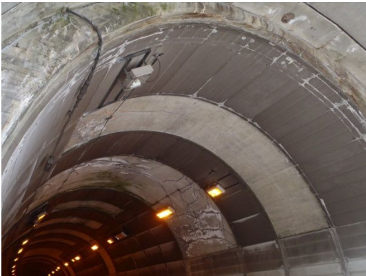
(e) ひび割れ注入工および面状導水工
