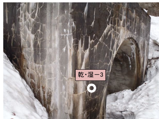
(b) 導水路トンネルへ進入する横坑の坑門
