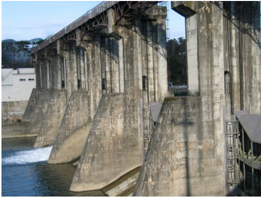
(a) コンクリートダム
