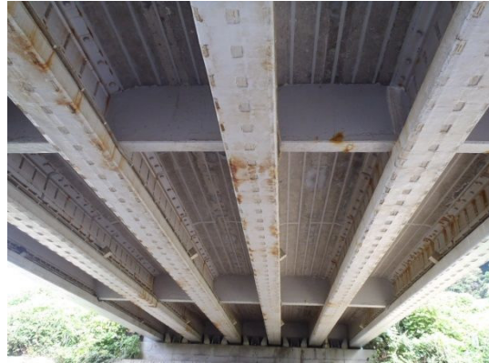
D 橋 桁下外観
