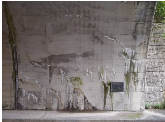
(i) トンネル I 覆工 (旧門前町産-安山岩砕石 A) (j) トンネル J 覆工 (旧能都町産-安山岩砕石 D) ASR の判定：乾湿繰返し部のひび割れ，白色析出物 ASR の判定：乾湿繰返し部ひび割れ，白色析出物
