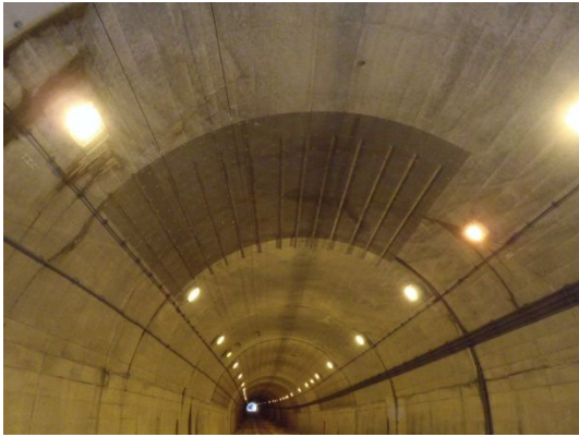
(d) 形鋼を併用した FRP メッシュ張付け工
