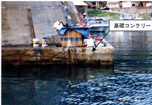
(a) 海中の基礎コンクリート
