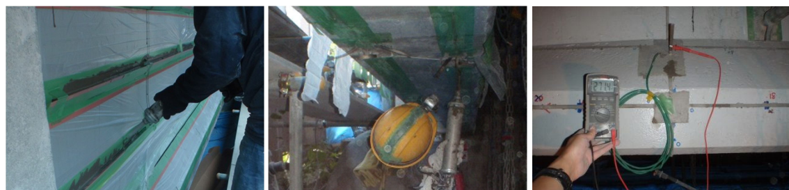
(g) 陽極被覆状況(主桁側面)
