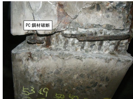
(b) G 橋 G8 桁下フランジ下面
