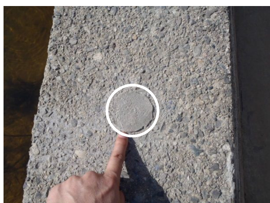
(c) 鉛直方向に鉄筋挿入
