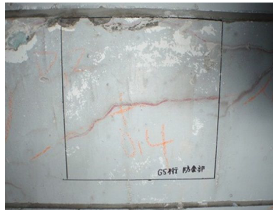
(a) J 橋 亀裂変位計によるひび割れ幅の測定箇所
