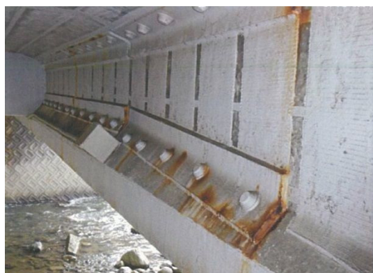
(a) 山側の主桁側面
