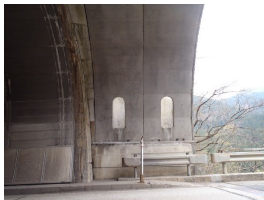
坑門の ASR によるはく落防止対策と坑口の崩落土や落石対策を兼用したもの
