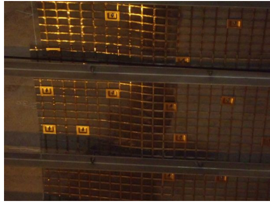
(d) 形鋼を併用した FRP メッシュ張付け工
