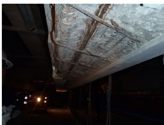
(c) J 橋の断面修復状況
