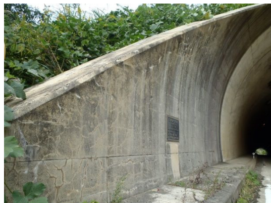
(k) トンネル K 覆工 (手取川産-川砂利 A) (l) トンネル L 坑門 (輪島市産-安山岩砕石 C) ASR の判定：乾湿繰返し部のひび割れ，白色析出物 ASR の判定：亀甲状ひび割れ，白色析出物
