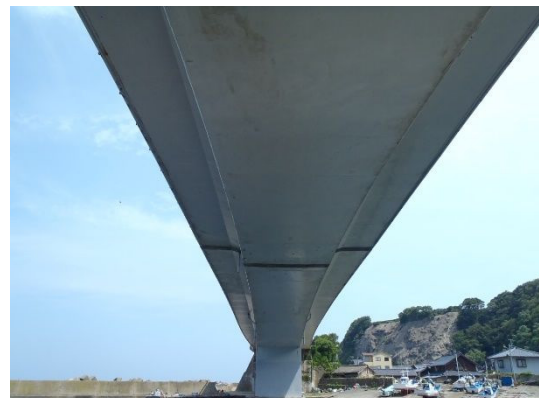
L 橋 桁下外観
