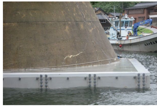
(d) 鋼板による保護工
