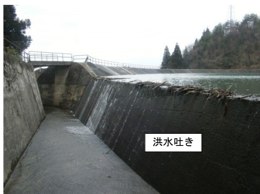
(a) ため池の洪水吐き（重力式擁壁）
