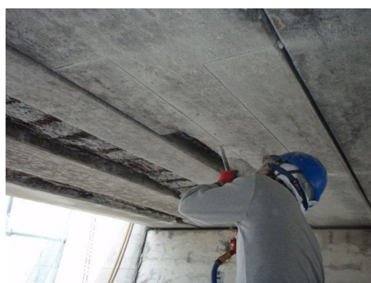
(d) K 橋の断面修復状況
