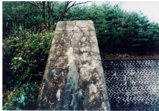
(g) トンネル G 坑門 ASR の判定：亀甲状ひび割れ，ゲル滲出による濡れ (h) トンネル H 坑門 (旧門前産-安山岩砕石 B) ASR の判定：水平方向に延びるひび割れ
