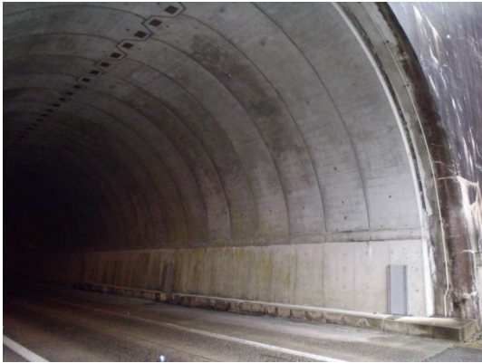
(a) プレキャストコンクリートライニング版 (PCL) 内巻き工
