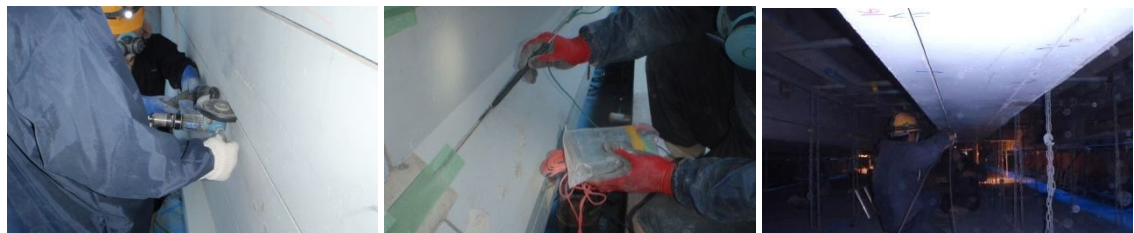
(d) 溝切削状況
