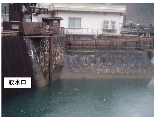
(a) コンクリートダムの取水口
