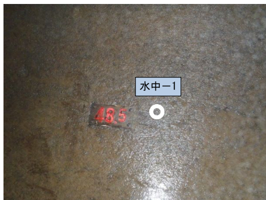
(a) 導水路トンネル内
