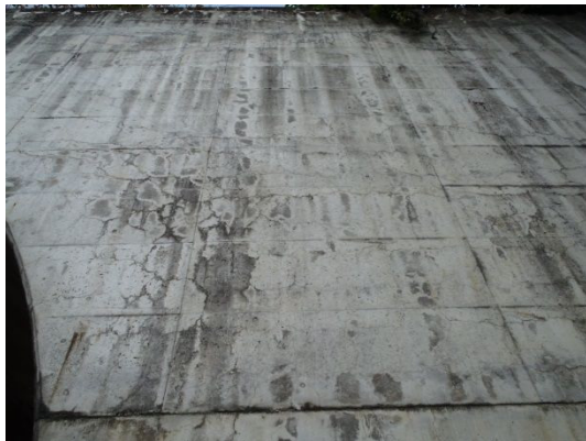
(e) トンネル E 坑門 (旧能都町産-安山岩砕石 D) ASR の判定：亀甲状ひび割れ (f) トンネル F 坑門 (手取川産-川砂利 A) ASR の判定：亀甲状ひび割れ，ゲル滲出による濡れ
