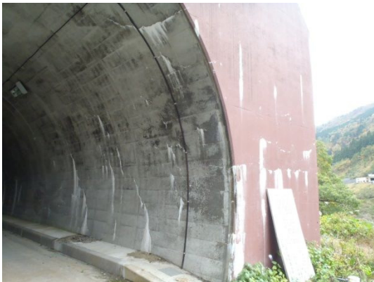
(k) トンネル K 覆工 (手取川産-川砂利 A) (l) トンネル L 坑門 (輪島市産-安山岩砕石 C) ASR の判定：乾湿繰返し部のひび割れ，白色析出物 ASR の判定：亀甲状ひび割れ，白色析出物
