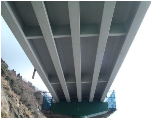
I 橋 桁下外観
