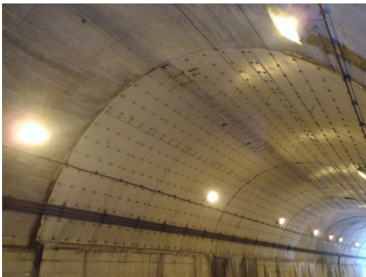
(b) 鋼板接着工
