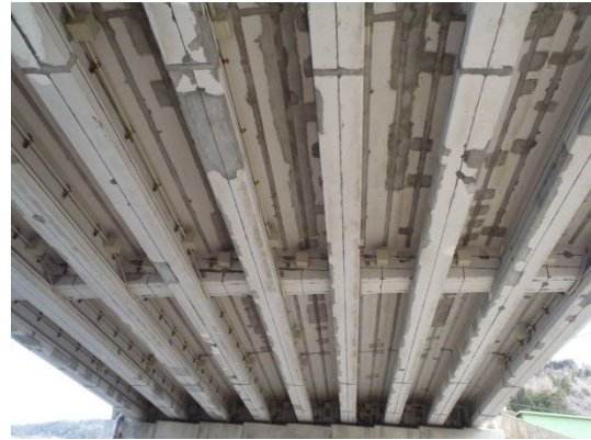
H 橋 桁下外観
