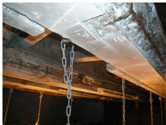
(b) G 橋の断面修復状況
