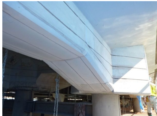
F 橋 桁下外観
