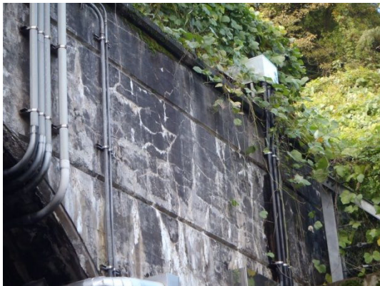
(g) トンネル G 坑門 ASR の判定：亀甲状ひび割れ，ゲル滲出による濡れ (h) トンネル H 坑門 (旧門前産-安山岩砕石 B) ASR の判定：水平方向に延びるひび割れ
