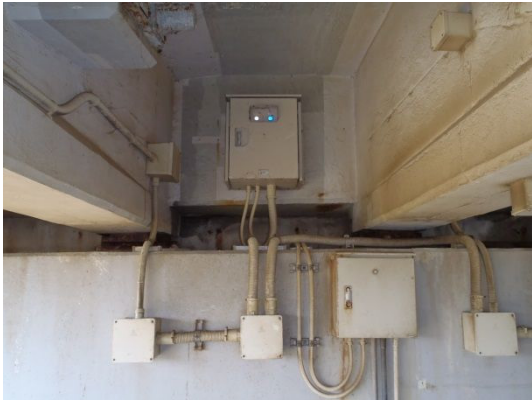
A 橋 桁下外観
