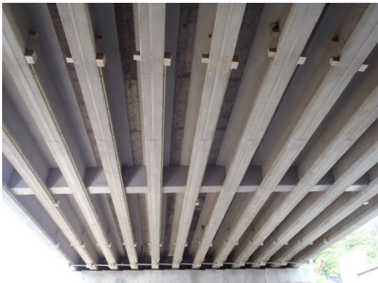
E 橋 桁下外観
