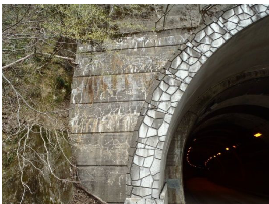
坑門の ASR によるはく落防止対策と坑口の崩落土や落石対策を兼用したもの
