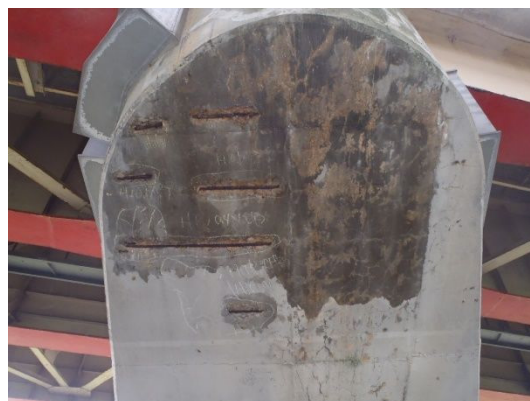
写真 4.4.1 道路橋の橋脚はり部におけるけい酸ナトリウム系補修材料塗布後の再劣化
