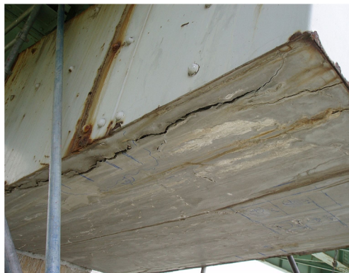
写真 2.3.10 鋼板とかぶりコンクリートが一体ではなく離れた事例（橋脚はり） 33)
