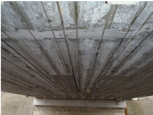
K 橋 桁下外観
