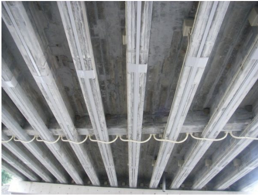
G 橋 桁下外観
