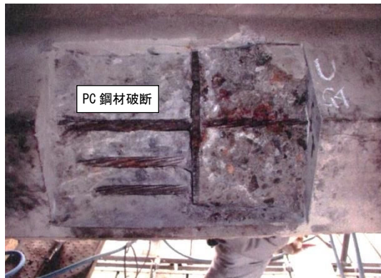
(a) E 橋 G4 桁下フランジ側面
