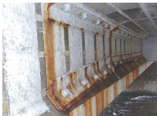
(b) 海側の主桁側面
