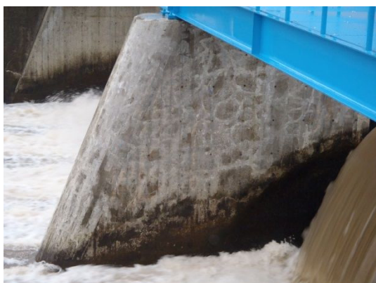
(c) 堰柱のひび割れ補修（補修後）
