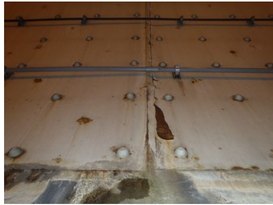
(b) 鋼板接着工
