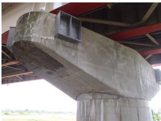
写真 4.4.1 道路橋の橋脚はり部におけるけい酸ナトリウム系補修材料塗布後の再劣化
