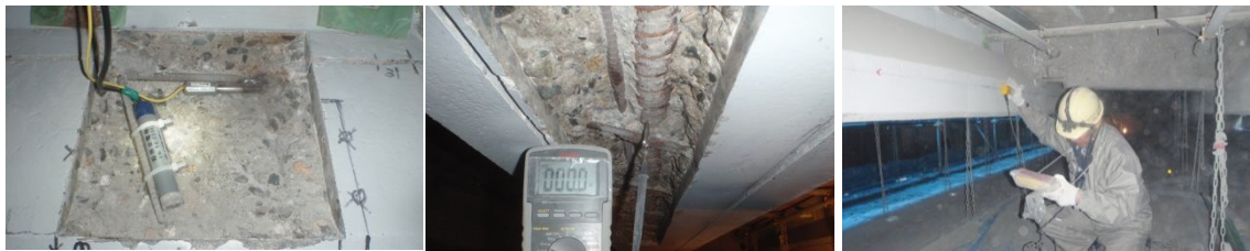
(a) 照合電極の設置状況
