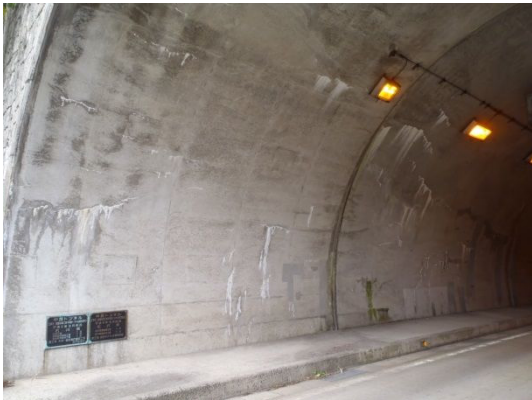
(i) トンネル I 覆工 (旧門前町産-安山岩砕石 A) (j) トンネル J 覆工 (旧能都町産-安山岩砕石 D) ASR の判定：乾湿繰返し部のひび割れ，白色析出物 ASR の判定：乾湿繰返し部ひび割れ，白色析出物
