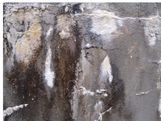
写真 4.2.9 サージタンクにおけるけい酸ナトリウム系補修材料塗布後の再劣化
