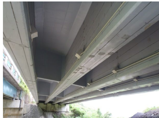
J 橋 桁下外観
