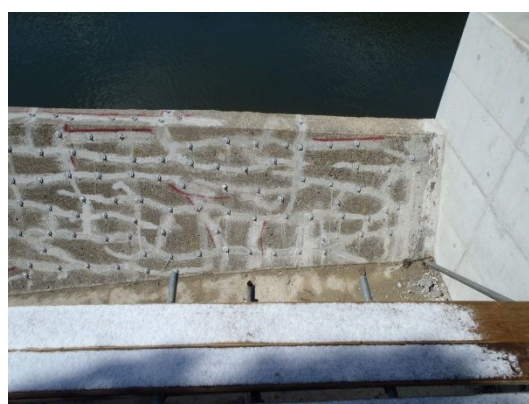
(d) ひび割れ注入工
