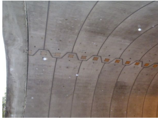
(a) プレキャストコンクリートライニング版 (PCL) 内巻き工
