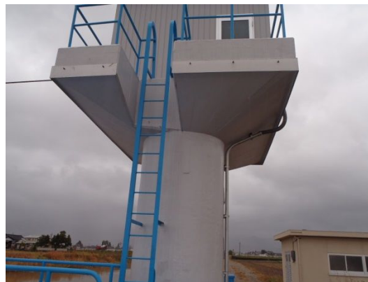
(d) 門柱および操作台の表面被覆工（補修後）
