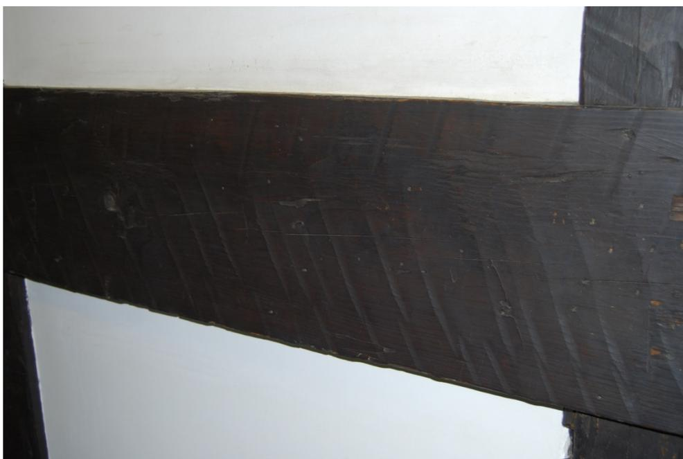
長野県「松本市立松本民芸館」二階腰部分の梁と柱のチョウナ跡である。煤で黒ずんだ構造材を磨けば、鉄のような色と輝きが生れてくる。
