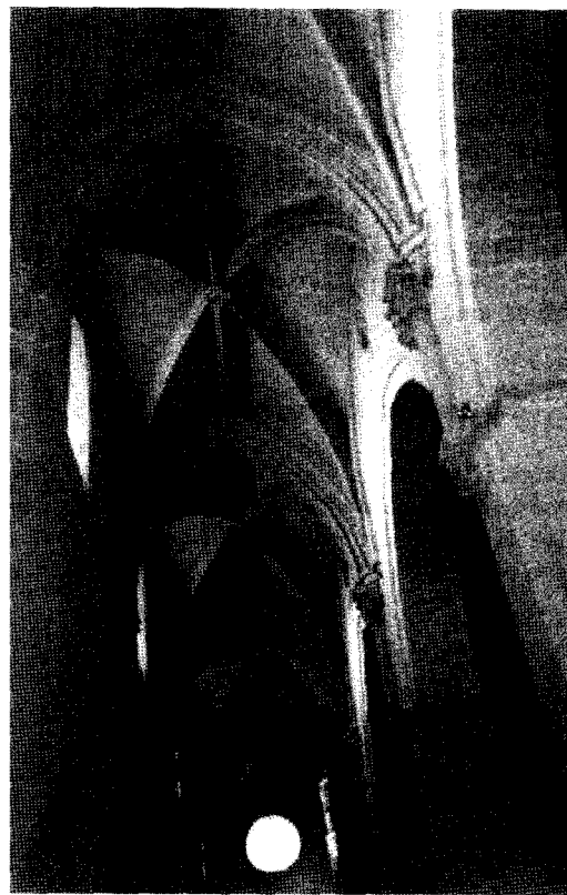
Figura 15 Bóvedas de la nave lateral
