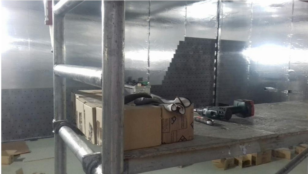
Figura 52: Recubrimiento de baldosas de ferrita durante la obra.
