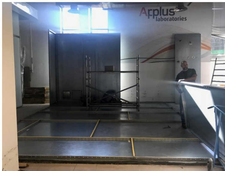
Figura 51: Montaje de la estructura blindada.
