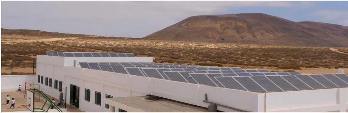
Figura 3-17. Colegio Instalación FV
