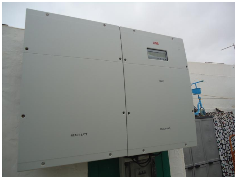
Figura 3-24. Inversor-Baterías instalados
