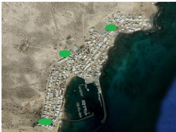
Figura 3-7. Distribución Centros de Transformación Isla de la Graciosa
