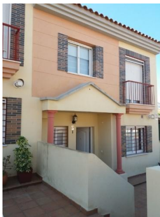
Figura 2-14. Fotografía del Edificio 4
