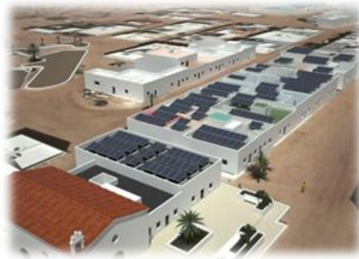
Figura 3-10. Implantación FV en azoteas
