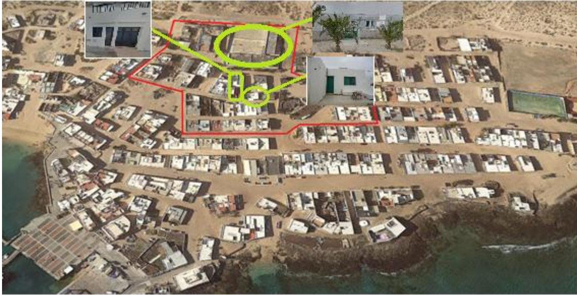
Figura 3-15. Edificios de Estudio Detallado
