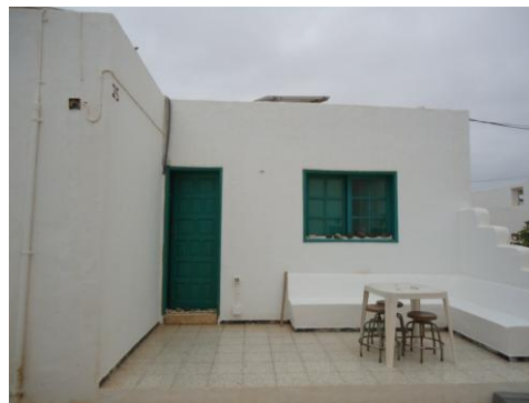
Figura 2-6. Fotografía del Edificio 2
