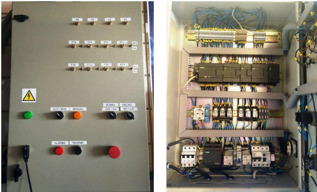
Figura 3.1 (a) Exterior del Armario de Mando y Control, (b) Interior del Armario de Mando y Control
