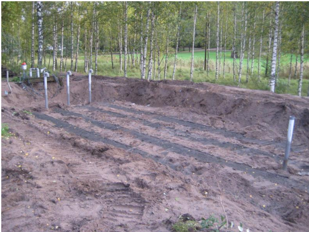
Kuva 30. Raaseporin maasuodatin valmiina näytteenoton aloittamista varten.
