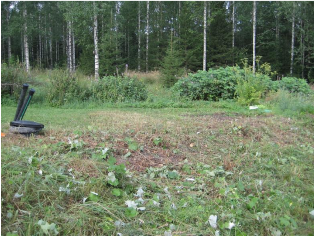
Kuopio 1. Tutkittu maasuodattamo. Kuvan vasemmassa laidassa jakokaivo ja kokoomaputkien päädyt. Maasuodattamo sijaitsee lyhyeksi leikatulla alueella. Pintapurkautumista oli havaittu kuvan oikeasta laidasta alkavan rinteeseen yläosassa.
