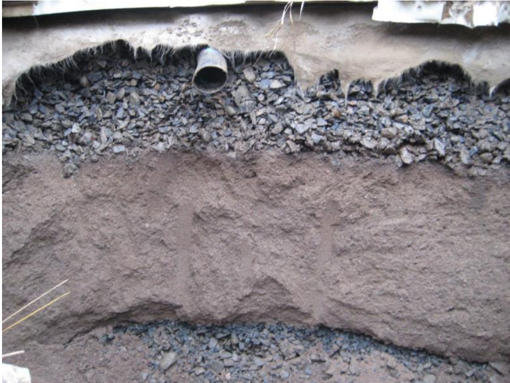
Tammela 3. Kuva näytteenottokuopan laidasta. Nähtävissä kaikki maakerrokset sekä yläpinnan suodatinharso ja routasuojalevyt.
