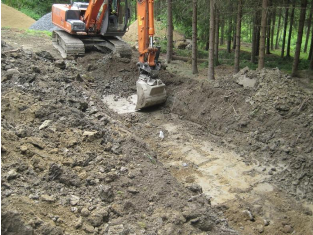
Akaa 5. Uuden maasuodattamon kaivanto.
