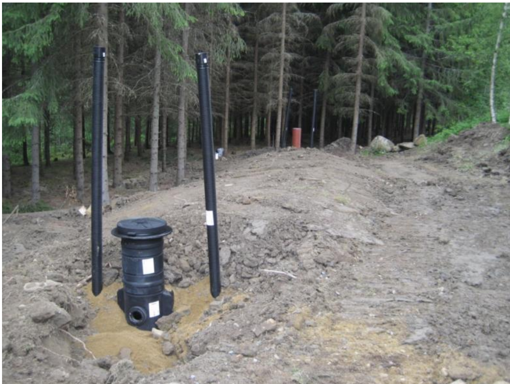
Akaa 8. Uusi maasuodattamo tuuletusputkien lyhennystä ja maisemointia vaille valmiina. Paikalle on suunniteltu nurmipinta.
