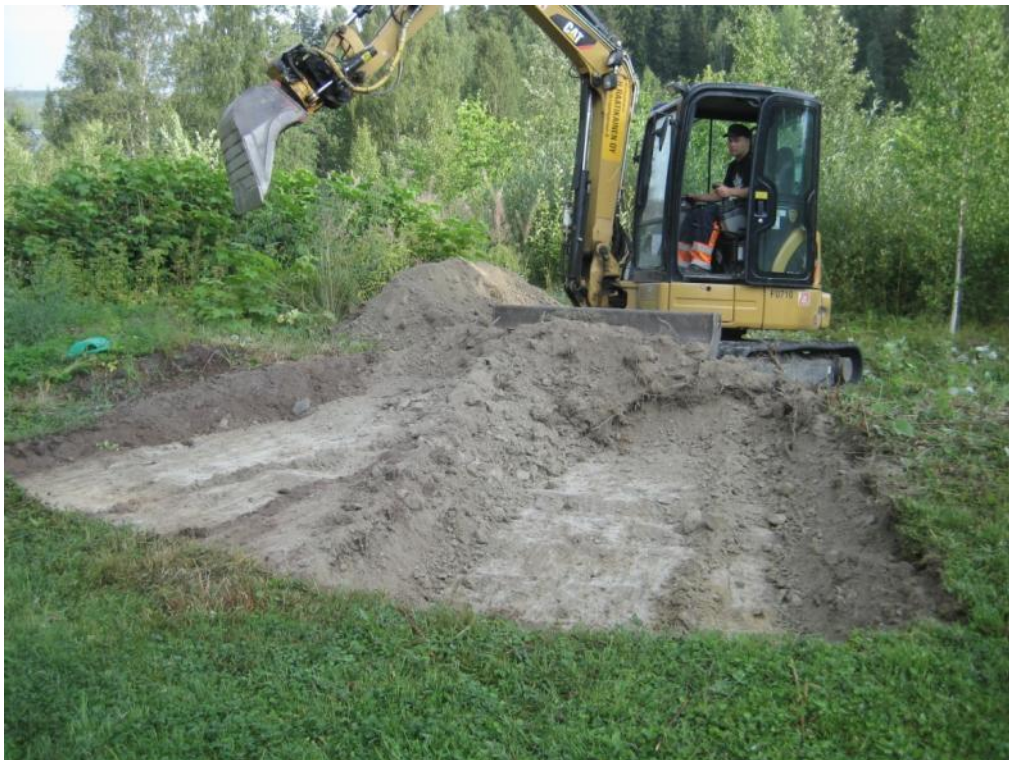
Kuopio 2. Näytteenottokuopan alkua ja käytössä ollut pieni kumitelainen kaivinkone.
