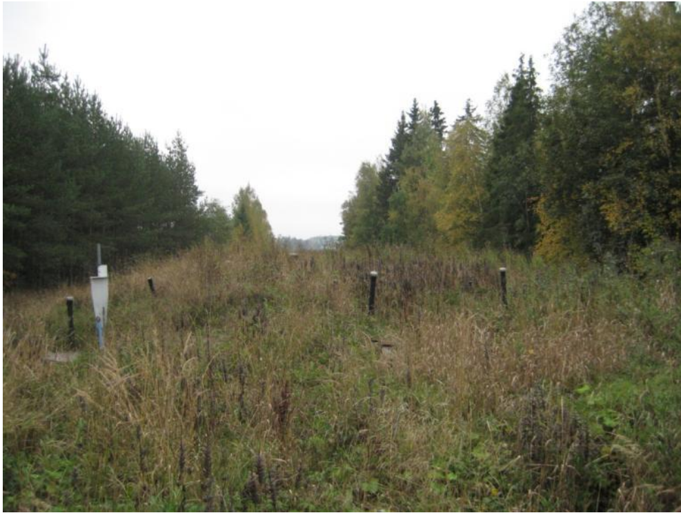
Tammela 1. Tammelassa tutkittu maasuodattamo. Kuva on otettu saostussäiliön vierestä. Kuvan vasemmassa laidassa nähtävissä pumppukaivon sähkötolppa. Lisäksi nähtävissä kokoomaputkien päätyjä ja taustalla heinän seassa yhden jakokaivon kansi.
