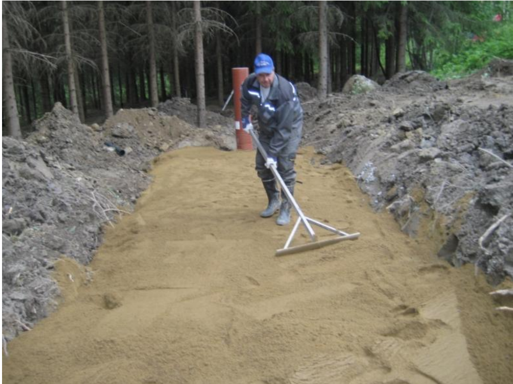
Akaa 7. Suodatinhiekan yläpinnan tasausta.
