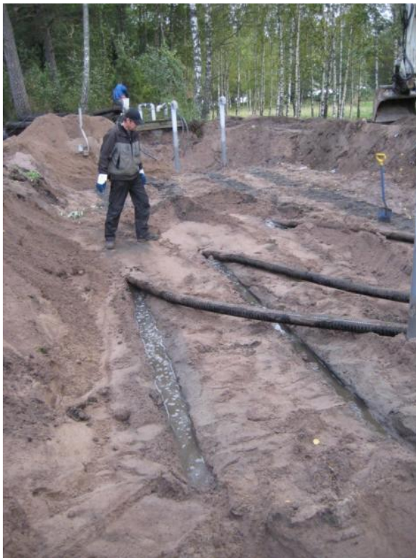
Raasepori 4 & 5. Vasemmalla kentän purkamista, näkyvissä vedellä täyttyneet tuuletusputket Fosfilt-hiekkakerroksen yläpinnalla. Oikealla lähikuva hiekan ja Fosfilt-hiekka-seoksen rajapinnasta, johon oli muodostunut rakenteeltaan tiiviimminkin tuntuinen tukkeumakerros.
