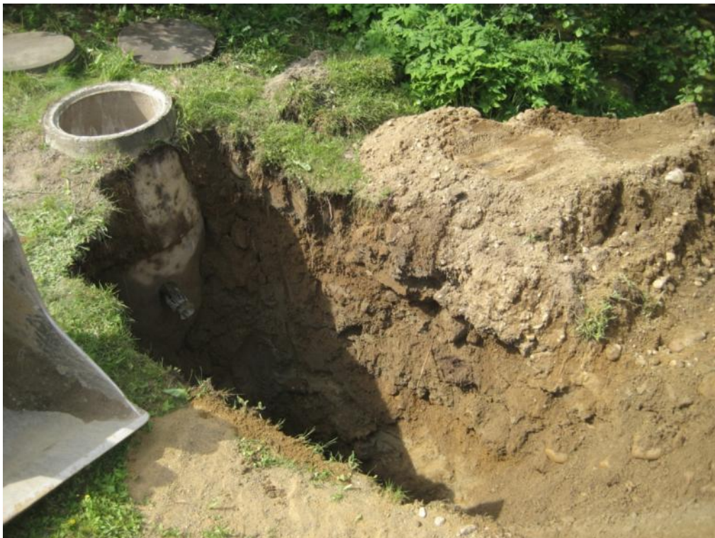
Akaa 10. Uuden sakokaivon paikka kaivettuna.
