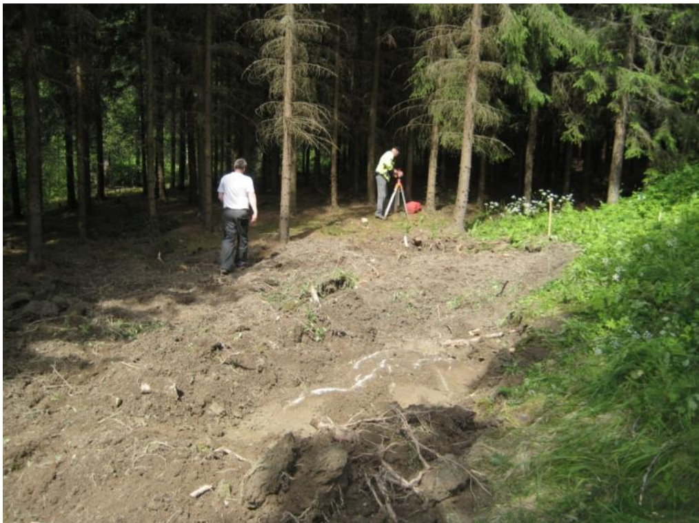
Akaa 4. Tukkeutuneen imeyttämön korvanneen Uponor- maasuodattamon rakennuspaikka. Kuvan etulaidassa on nähtävissä suunnitellun rakennuspaikan kohdalta paljastunut kalliopinta tai suuri kivi, jonka takia suodattamo rakennettiin hieman suunnitellun paikan sivulle.
