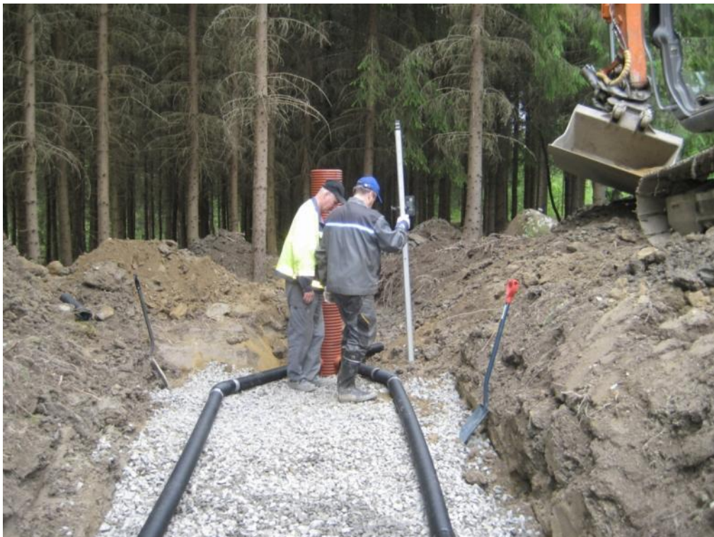
Akaa 6. Uuden maasuodattamon kokoomaputkiston ja kaivon asennusta.
