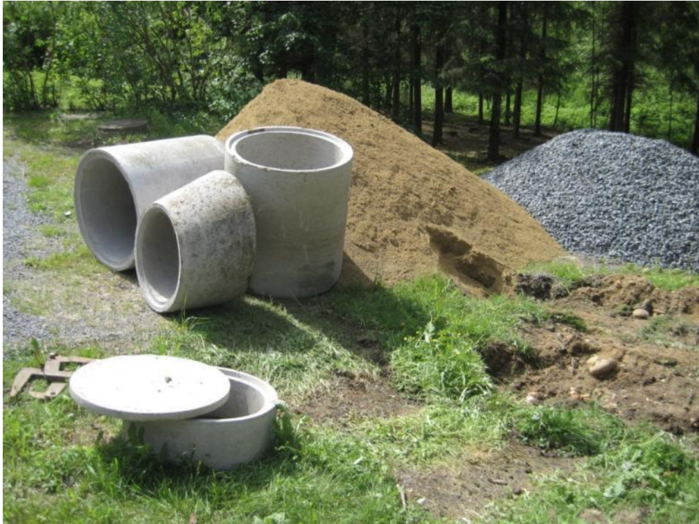
Akaa 9. Uuden suodattamon rakentamiseen käytetyt hiekka- ja sepelikasat sekä järjestelmään lisätyn kolmannen sakokaivon renkaat.
