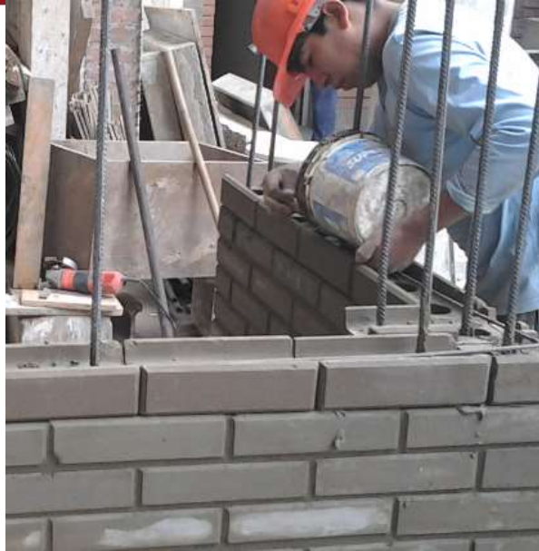
Fig.4.2. Alveolos con mortero.
