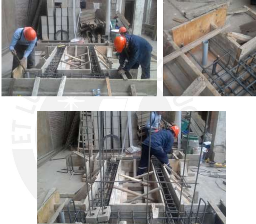
Fig. 6.3 Trabajos de encofrado, armado de refuerzo y fijación de puntos de anclaje.
