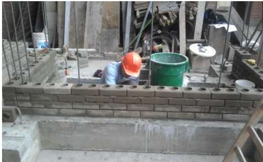
Fig. 6.6 Asentado de las primeras hiladas de ladrillo.
