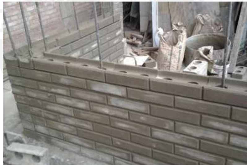
Fig.4.4. Viga con ladrillos ecológicos.
