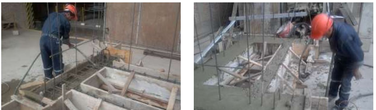
Fig. 6.4 Vaceado de la cimentación.
