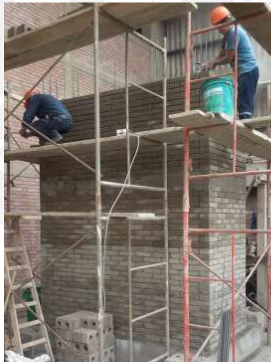
Fig. 6.10 Armado de los muros del segundo nivel.
