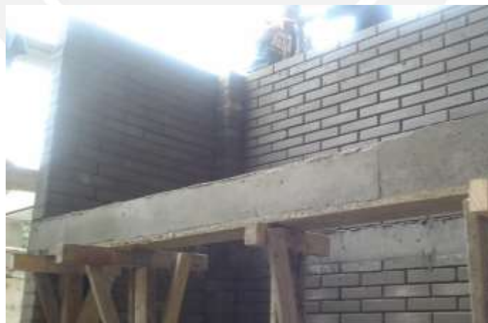
Fig.4.3. Viga solera del primer nivel.
