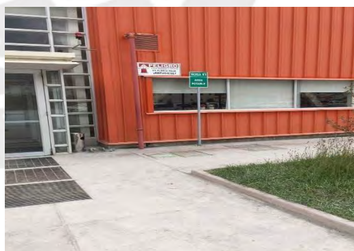
Figura P 6: Sistema de Alarmas
