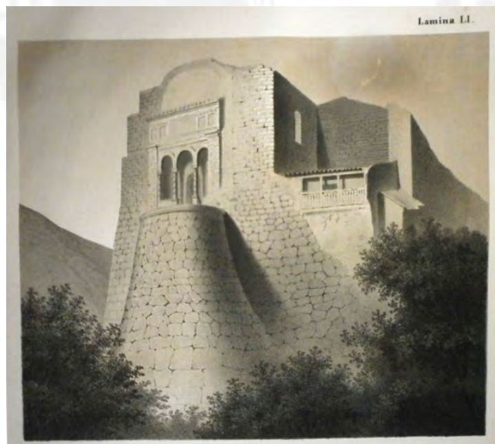
FIG. 11: Instituto litográfico de D. Leopoldo Müller. Vista de la parte del Convento de Santo Domingo de Cuzco construida sobre los restos del templo del sol. ca. 1851. Grabado. Tomado de Rivero y Tschudi 1851: lámina 51.
