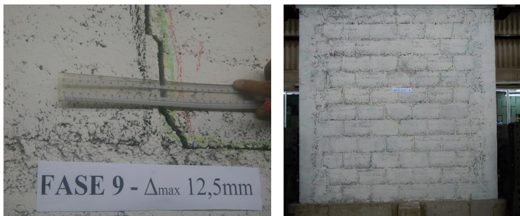
Fig. 5-33. Fase 9: Grietas llegaron al espesor de 1.0cm.
