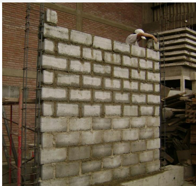
Fig. 5-9. Muro finalizando la última jornada de trabajo.
