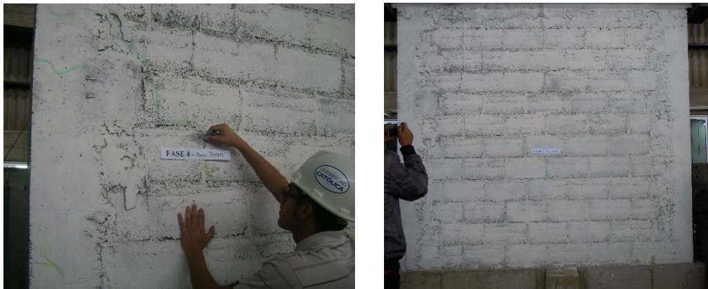
Fig. 5-28. Fase 4: Aparecen las primeras fisuras en la albañilería.
