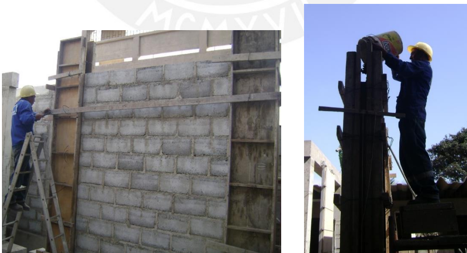
Fig. 5-15. Encofrado y vaciado de columnas de confinamiento.
