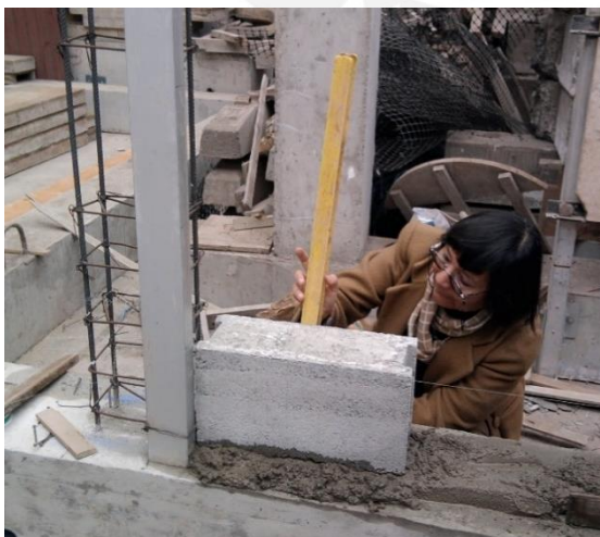
Fig. 5-11. Verificación de verticalidad y horizontalidad del muro.
