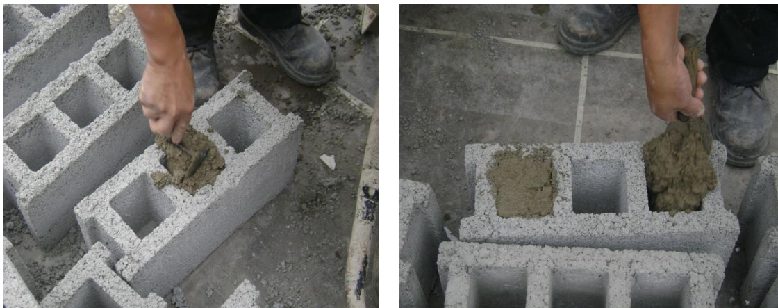
Fig 4-3. Relleno de los alveolos con mortero 1:8.
