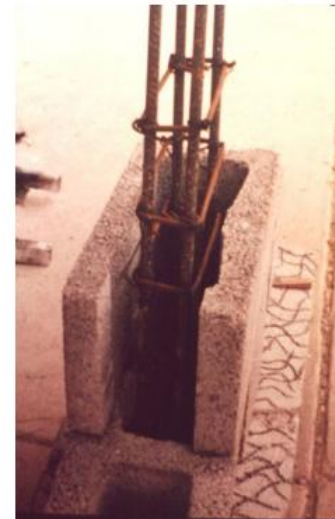
Fig 2-2. Bloque hueco con refuerzo vertical
