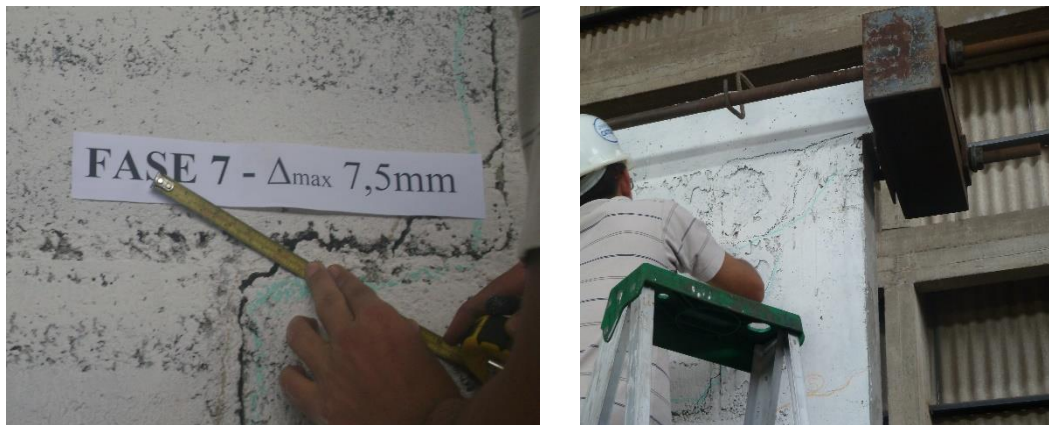
Fig. 5-31. Fase 7: Aparición de fisuras en conexión viga solera-columna.
