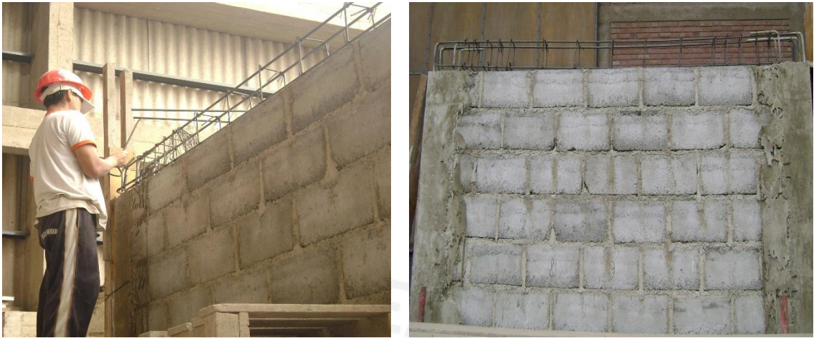
Fig. 5-16. Armado de la viga solera.
