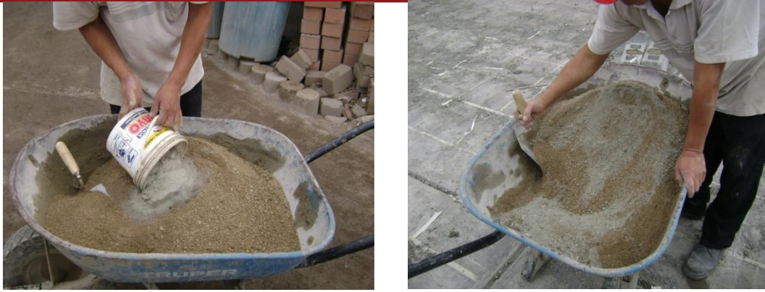
Fig. 4-1. Preparación del mortero para el llenado de los alveolos.
