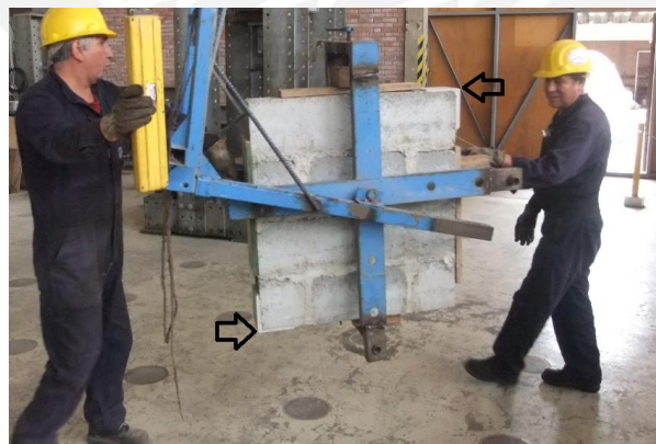
Fig. 4-23. Muretes con capping colocado en sus extremos
