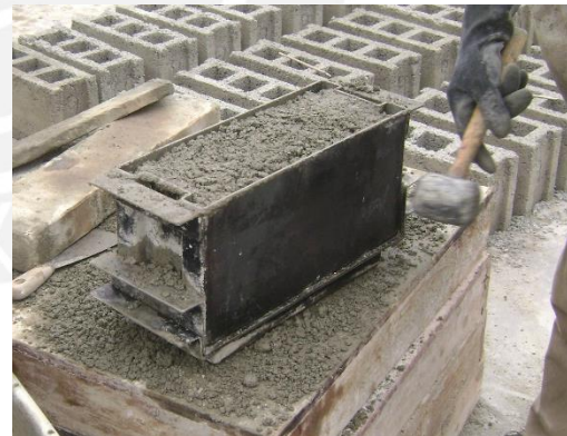
Fig 3-6. Compactado del mortero.
