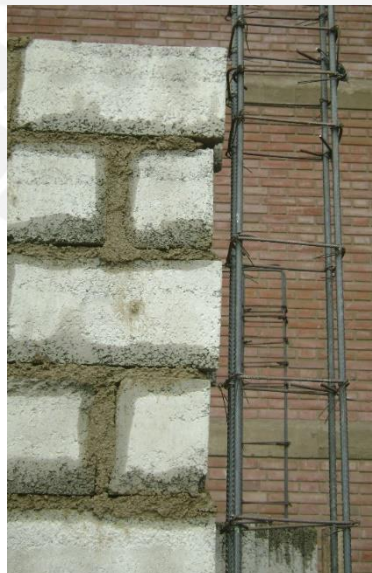
Fig. 5-13. Dentado del muro para garantizar el confinamiento.
