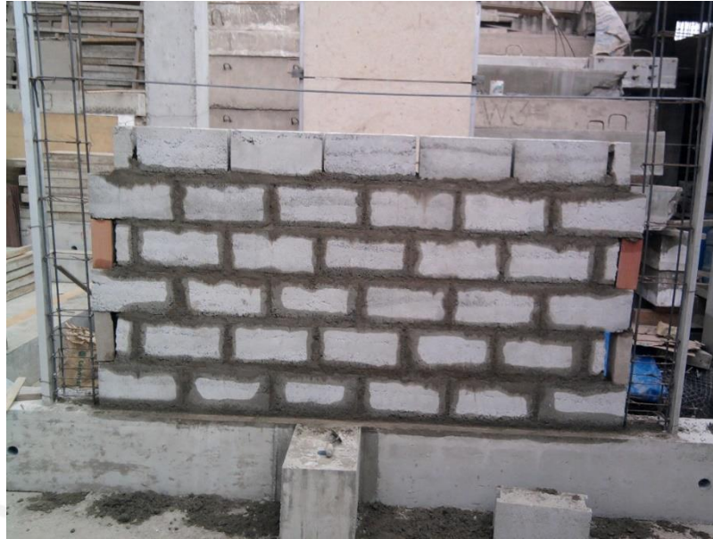
Fig. 5-8. Muro tras finalizar la primera jornada de trabajo.
