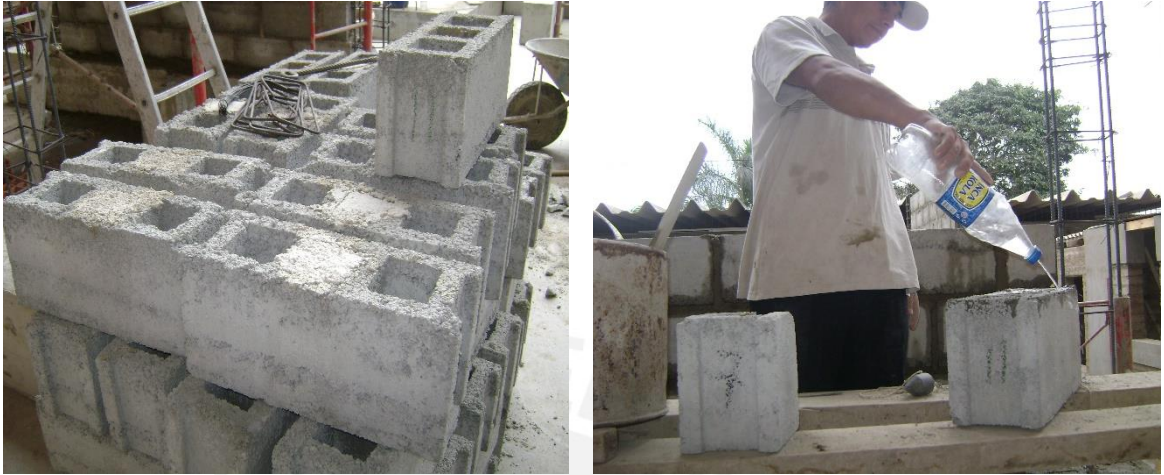
Fig. 5-6. Preparación de las unidades de albañilería antes del asentado.
