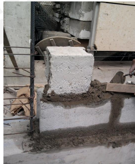
Fig. 5-11. Verificación de verticalidad y horizontalidad del muro.
