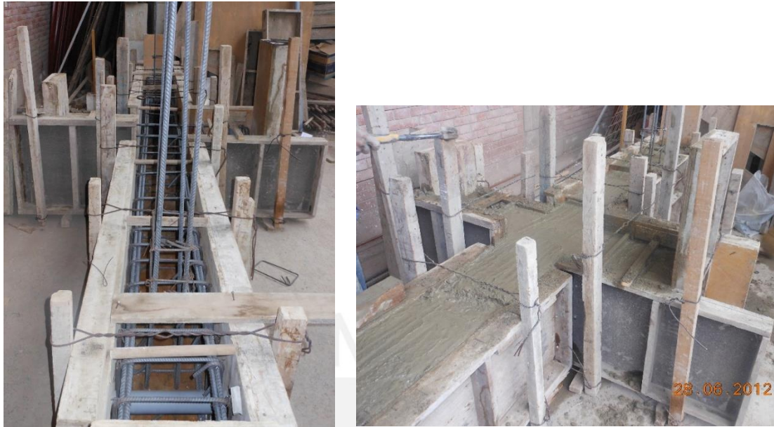
Fig. 5-5. Encofrado y vaciado de viga de cimentación
