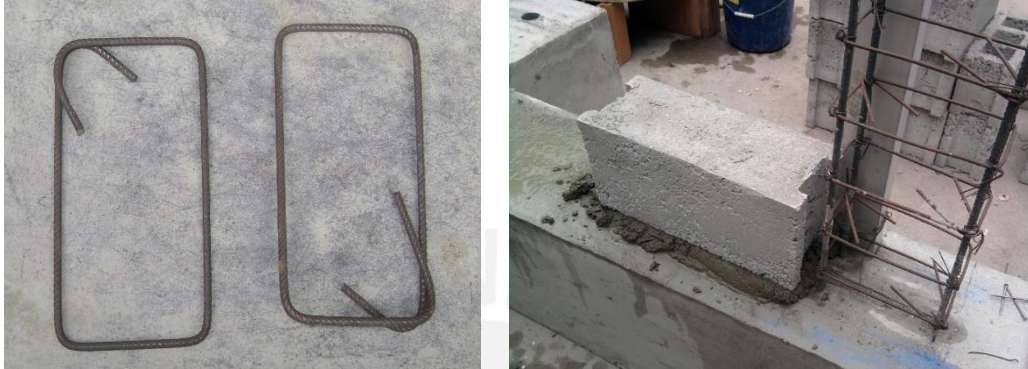
Fig. 5-14. Uso de bloques partidos para completar hilera de muro.
