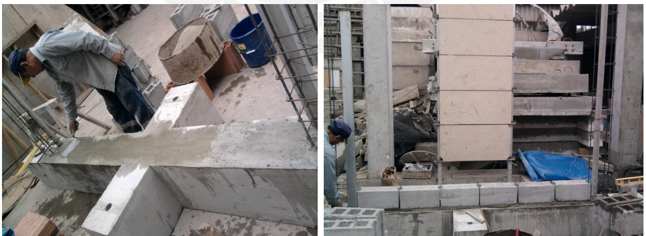
Fig. 5-7. Construcción de la primera hilada.
