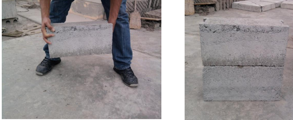
Fig 4-10. Simulación de asentado de unidades de concreto huecos.
