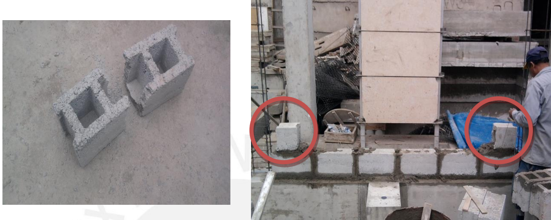
Fig. 5-12. Uso de bloques partidos para completar hilera de muro.
