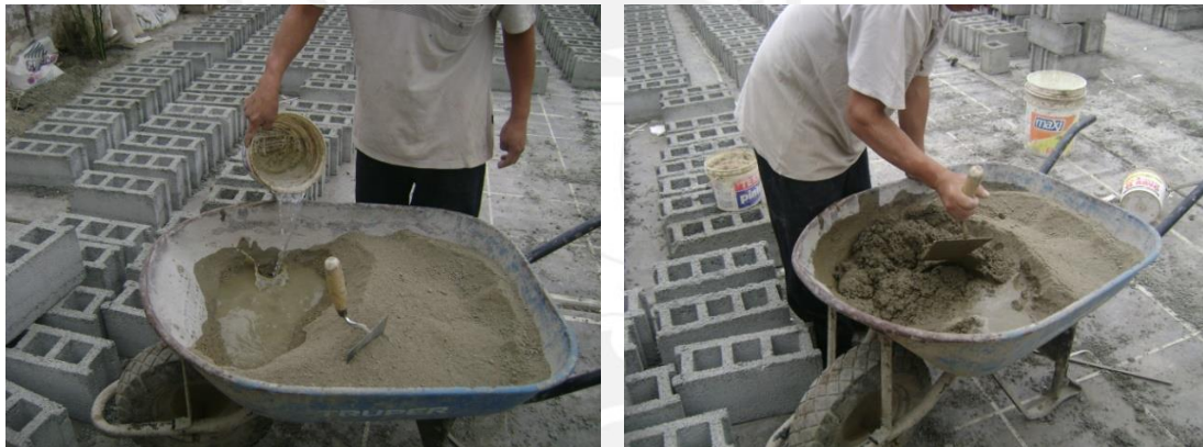
Fig 4-2. Vaciado de agua de mezclado para el relleno de alveolos.
