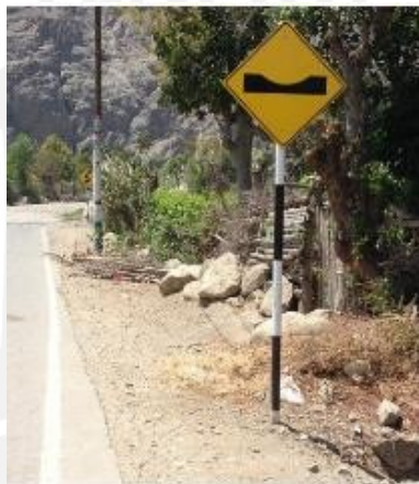
Figura 31: Señalización de badén.
