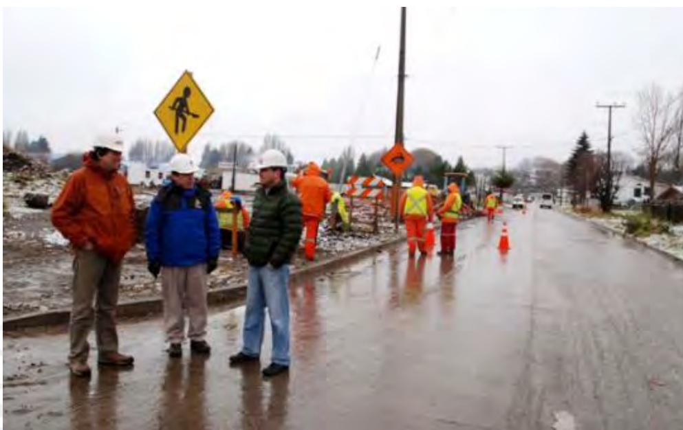
Figura 47. Tiempos muertos en construcción por lluvias. Tomado de Obras en Calle Ogana de Coyhaique se extenderán por construcción de colector de aguas lluvias , por C. Díaz, 2012 ( http://www.elpatagondomingo.cl/?p=29110 ).
