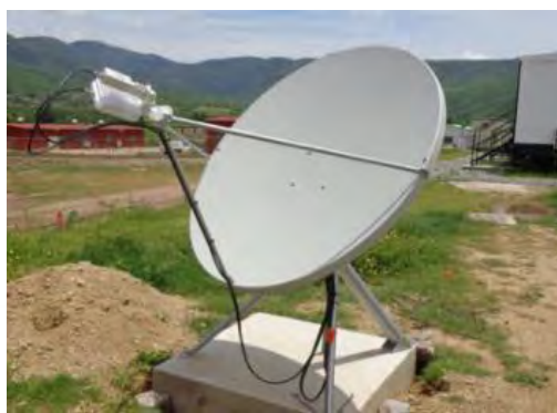
Figura 43. Antena satelital para Internet dedicado en zonas remotas.
