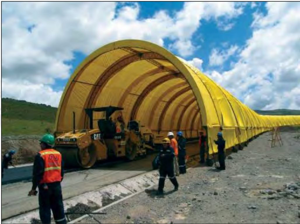
Figura 48. Coberturas para la reducción de tiempos muertos durante lluvias.
