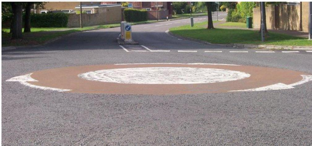
**Figura 36: Fotografía de una mini rotonda.**
