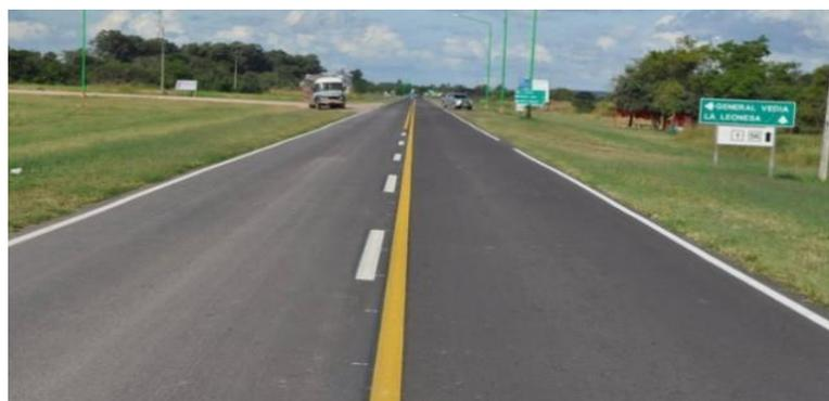
Figura 20: Pavimento flexible
