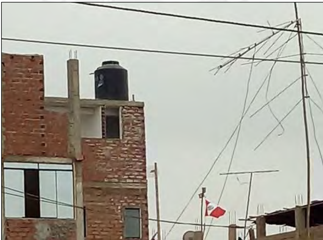
Figura 6.1. Tanque de agua en vivienda del Centro Poblado El Carmen
