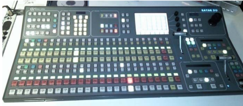
Figura 2.3 - Grass Valley™ KayakDD™ Instalaciones de ATV, Andina de Radiodifusión.
