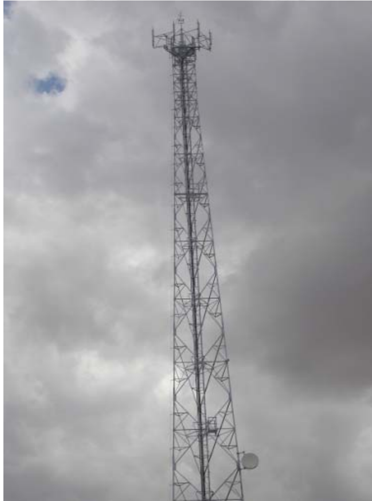
Figura 4.16: Torre Autoportada de 30 metros
