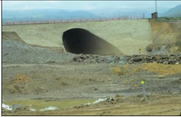
Figura 33. Vista del túnel. En la parte superior se visualiza la carretera hacia Huamachuco. (Elaboración propia)
