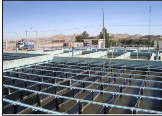
Figura 3.4 Zona de floculadores
