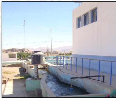
Figura 3.3 Zona de mezcla rápida y dosificación
