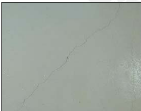
Fig. 8.05 Grieta de falla por corte (Flores 2002)
