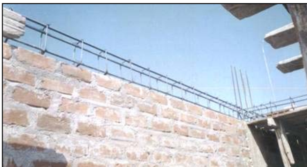
Fig. 7.30 Estribos en vigas de confinamiento
