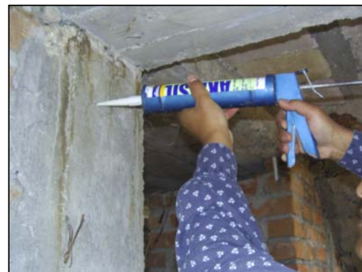
Fig. 8.23 Inyección de grietas con resina epóxica
