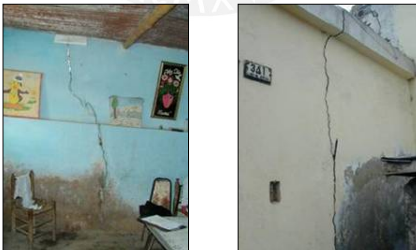
Fig. 5.24 Muros agrietados
