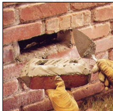
Fig. 8.20 Colocación de nuevo ladrillo (Black & Decker 2000)
