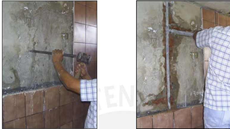
Fig. 8.39 Picado de muro
