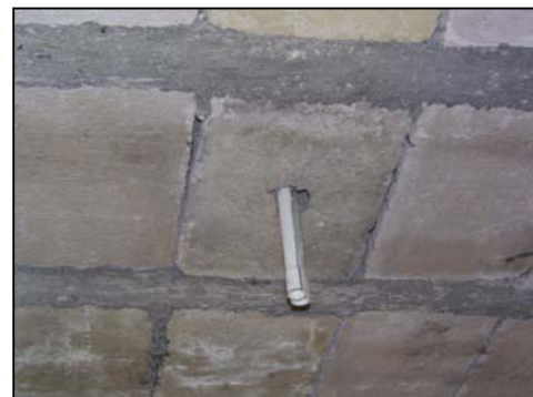
Fig. 7.35 (a) Inadecuada ubicación de los centros de luz; (b) Adecuada ubicación de los centros de luz
