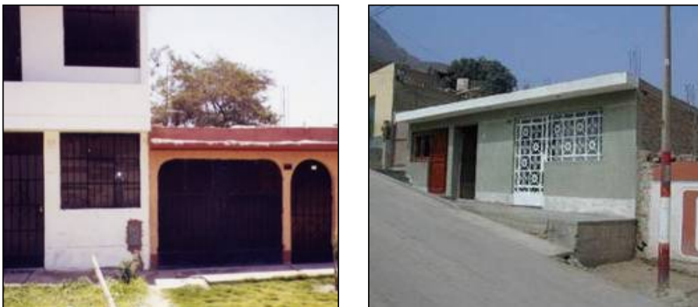
Fig. 5.13 Viviendas vecinas sin junta sísmica y losa de techo a desnivel
