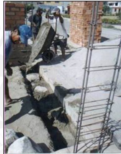
Fig. 7.16 Excavación de zanjas para la cimentación Fig. 7.17 Llenado de concreto en la cimentación
