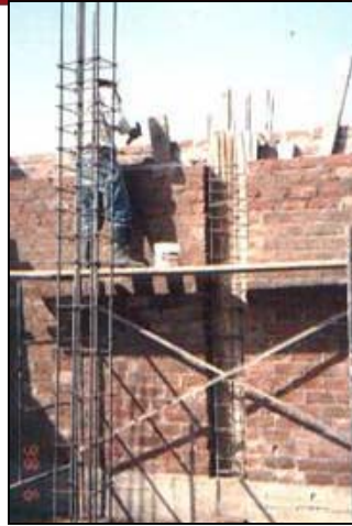
Fig. 7.25 Columna de confinamiento
