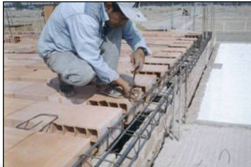
Fig. 7.29 Viga de confinamiento
