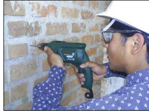
Fig. 8.08 Perforaciones con el taladro
