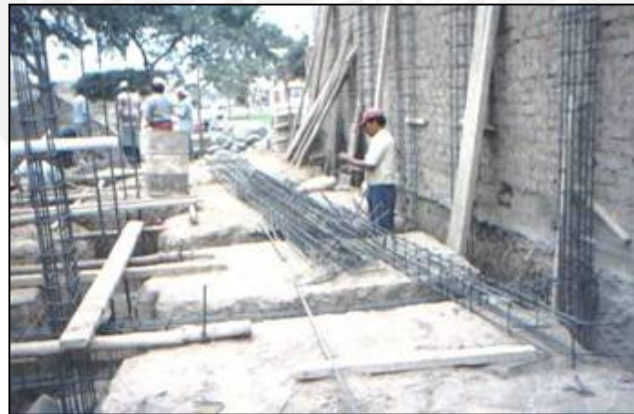
Fig. 7.24 Armado de las columnas
