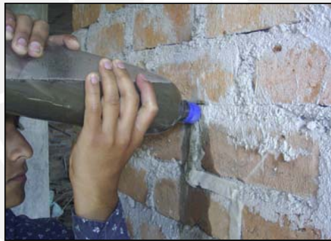
Fig. 8.12 Inyección de grietas con lechada de cemento
