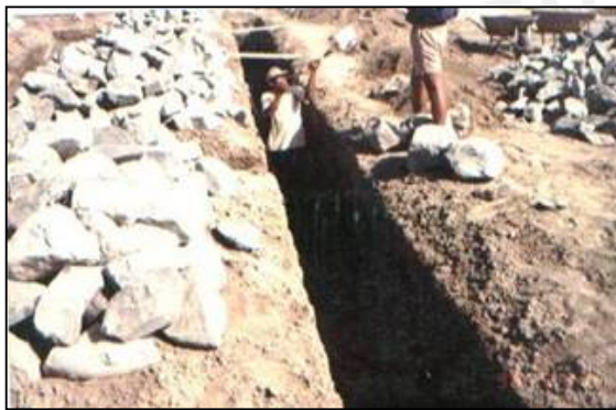
Fig. 7.16 Excavación de zanjas para la cimentación Fig. 7.17 Llenado de concreto en la cimentación
