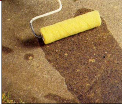
Fig. 8.36 Aplicación de solución limpiadora (Black & Decker 2000)
