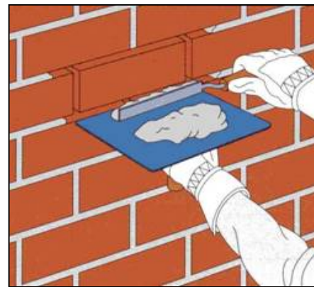
Fig. 8.17 Colocación de nuevo mortero (Life books 1995)
