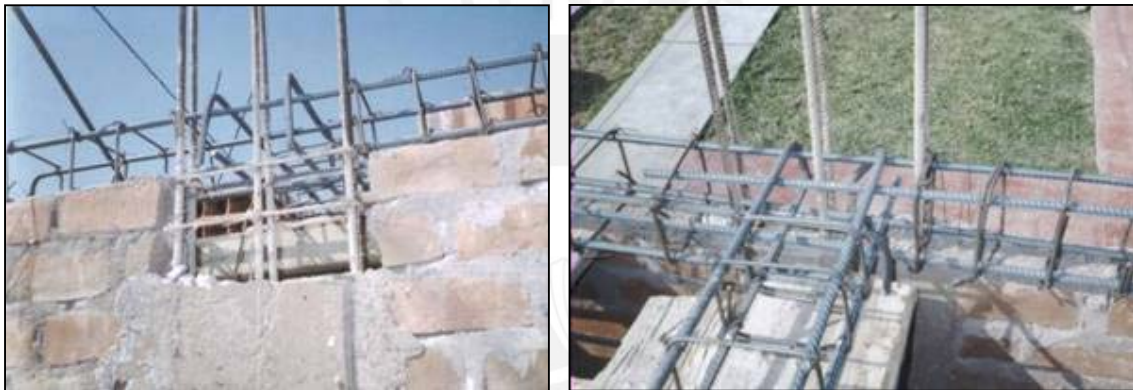
Fig. 7.32 Conexión columna y viga de confinamiento
