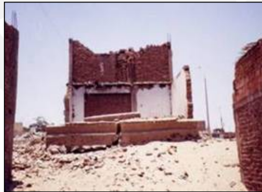
Fig. 5.03 Vivienda sobre suelo no consolidado
