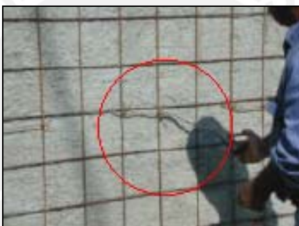
Fig. 8.49 Fijado de la malla electrosoldada
