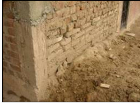
Fig. 5.18 Muro constituido con adobe y ladrillo de arcilla
