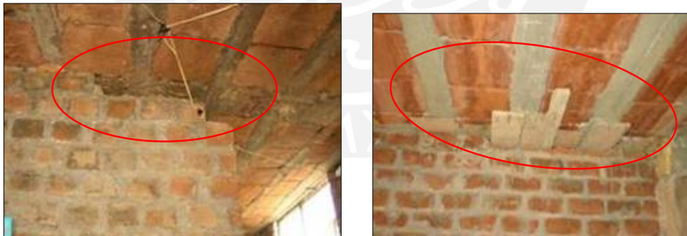
Fig. 5.19 Remoción de ladrillos en la unión muro, viga solera y techo
