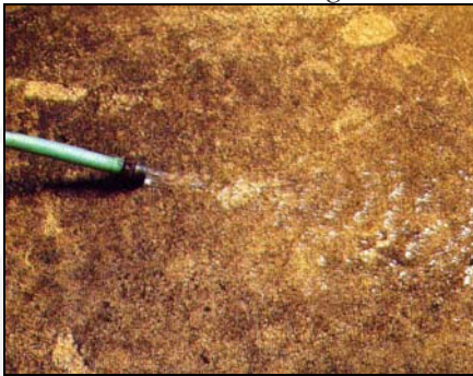
Fig. 8.37 Enjuague de la superficie con agua (Black & Decker 2000)
