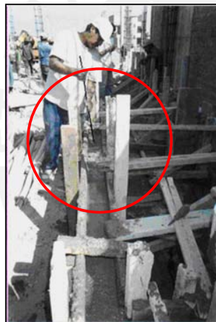
Fig. 7.19 Chuceado del sobrecimiento
