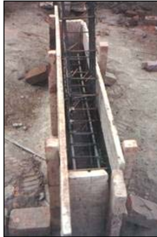
Fig. 7.18 Sobrecimiento armado
