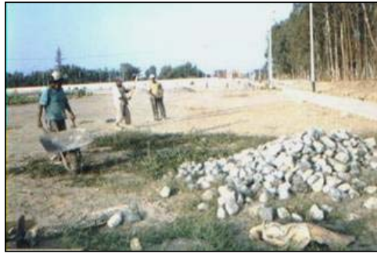
Fig. 7.10 Limpieza del terreno.
