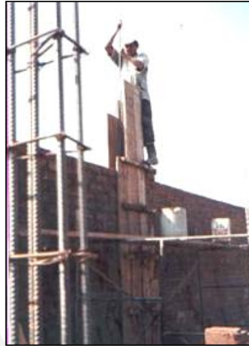
Fig. 7.27 Chuceado del concreto de columna
