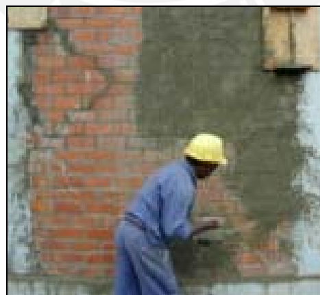
Fig. 8.47 Pañeteo del muro
