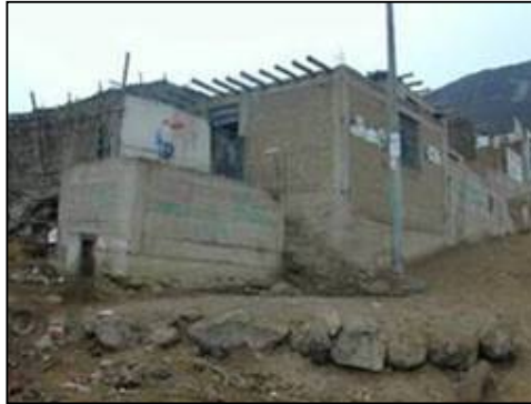
Fig. 5.01 Vivienda sobre relleno de nivel
