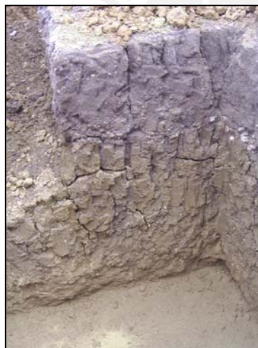
Fig. 7.08 Suelo arcillo expansivo
