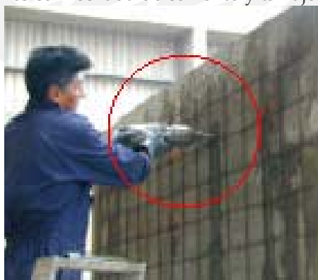
Fig. 8.50 Inyección de perforaciones
