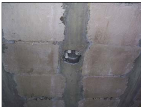
Fig. 7.35 (a) Inadecuada ubicación de los centros de luz; (b) Adecuada ubicación de los centros de luz
