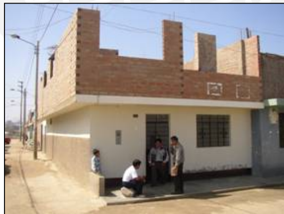
Fig. 5.11 Tabiquería no arriostrada en segundo piso
