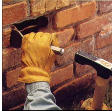
Fig. 8.18 Extracción de ladrillo (Black & Decker 2000)
