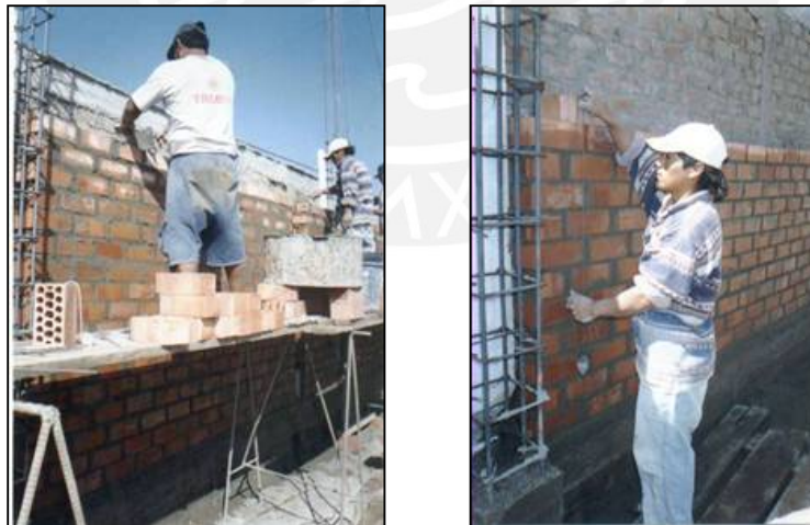
Fig. 7.21 Construcción de muros de ladrillos
