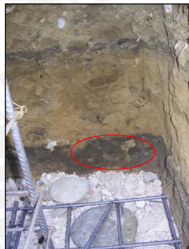
Fig. 7.09. Suelo de relleno.
