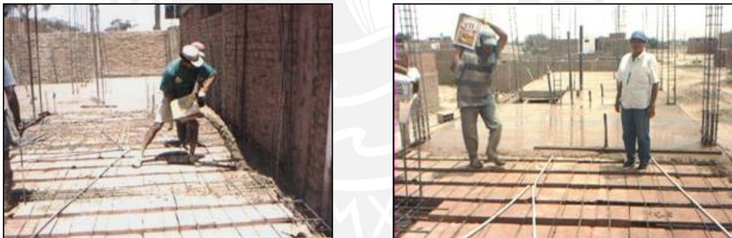
Fig. 7.36 Proceso de llenado de la losa aligerada
