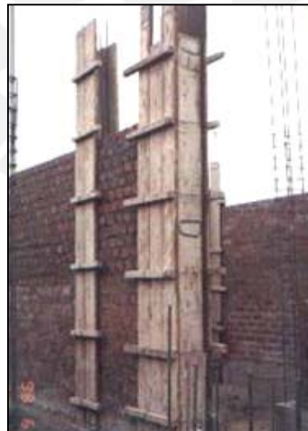
Fig. 7.26 Encofrado de columnas
