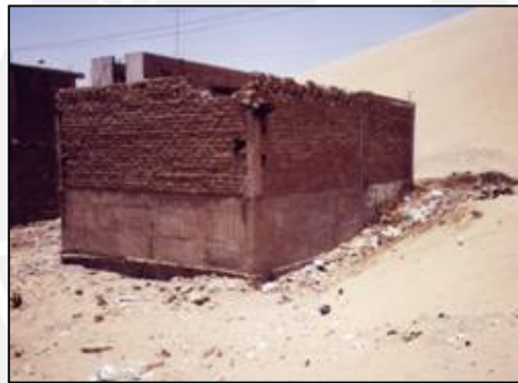
Fig. 5.05 Vivienda ubicada en suelo arenoso
