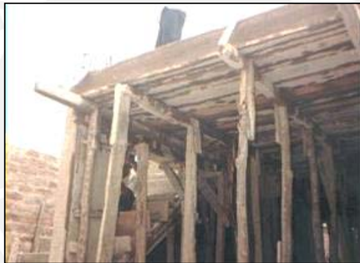
Fig. 7.34 Encofrado de losa aligerada
