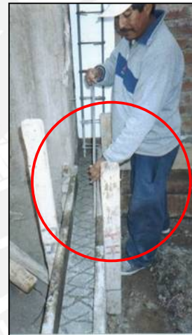
Fig. 7.20 Rayado del sobrecimiento
