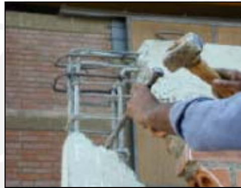
Fig. 8.46 Picado del nudo viga columna
