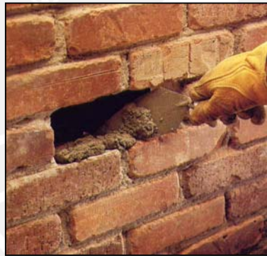
Fig. 8.19 Colocación de nuevo mortero (Black & Decker 2000)
