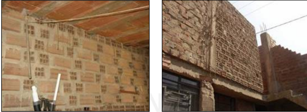
Fig. 5.06 Muros de ladrillo pandereta
