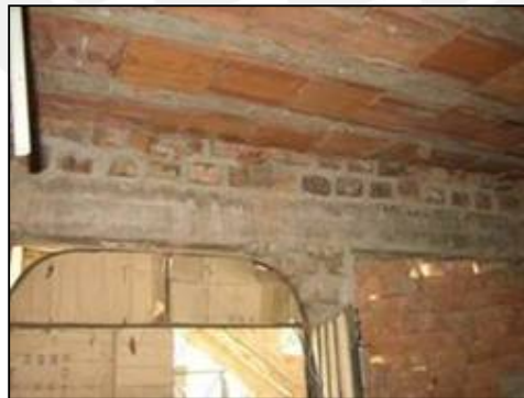
Fig. 5.08 Hileras de ladrillos sobre viga solera
