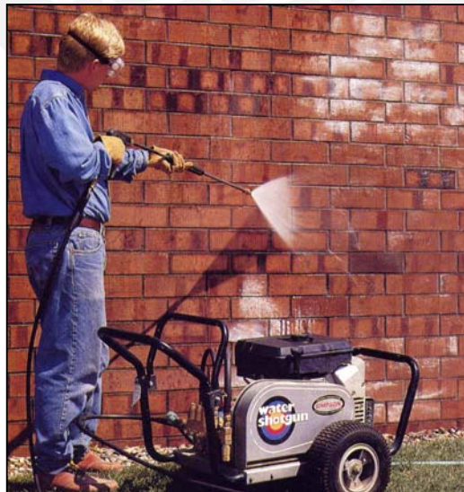
Fig. 8.10 Lavado de grietas (Black & Decker 2000).
