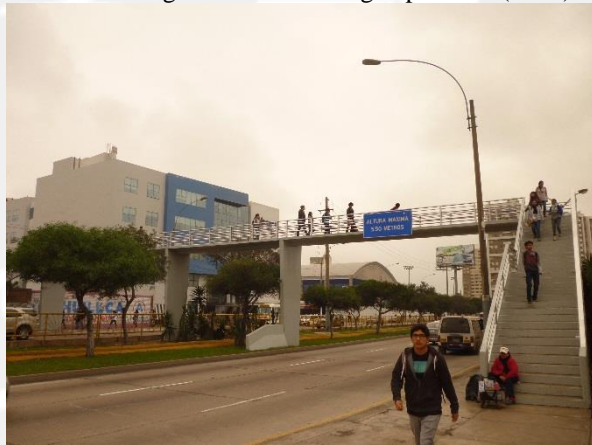
Figura 1.10: Puente peatonal y rejas amarillas para que peatones no crucen a la puerta peatonal ciencias Fuente: Propia (2015)
