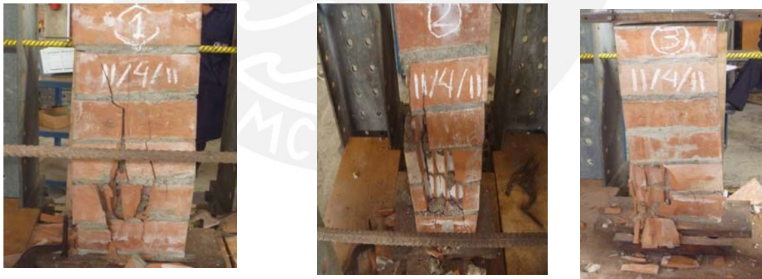
Figura 4.1 Forma de Falla de las pilas 1, 2 y 3, respectivamente.
