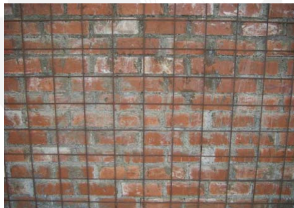
Figura 6.4 Malla electrosoldada en el muro M2
