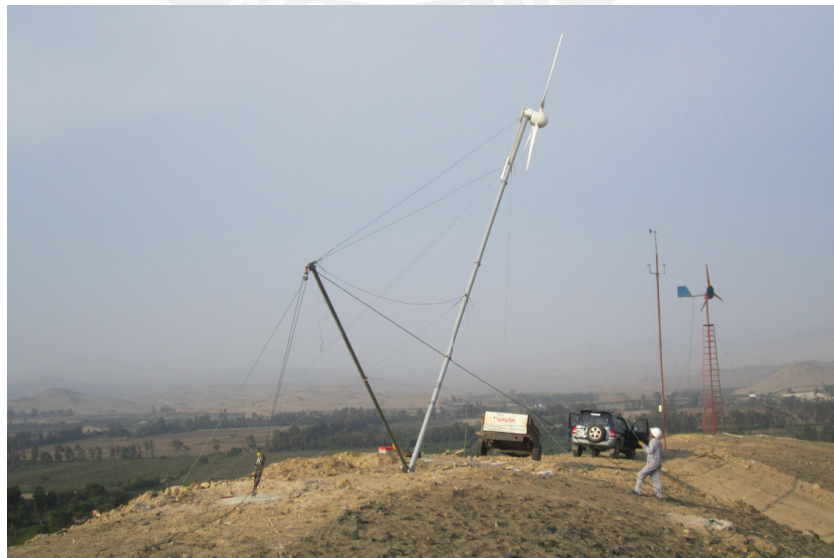
Figura 1.11 Montaje de aerogenerador. Cortesía de Waira Energía SAC.
