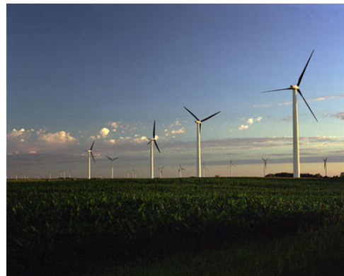
Figura 1.2 Aerogeneradores de grandes potencias para producción masiva de energía eléctrica – Lone Star Wind Farm – Texas – EE.UU. Fuente: http://assets.inhabitat.com/files/windt2.jpg
