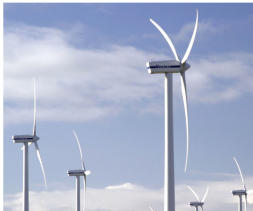
Figura 1.12 Deflecciones en paletas de aerogeneradores Vestas V80 [4].
