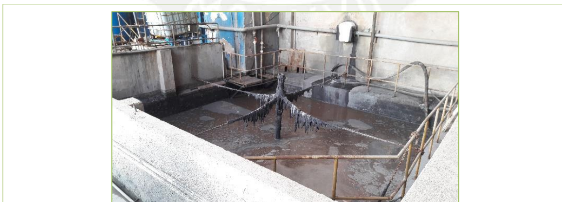
Poza de efluentes. Fotografía tomada en la Planta de la Curtiembre la Pisqueña, en Ica.
