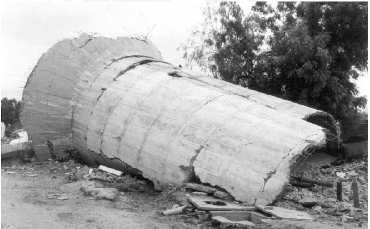
Figura 2.1- Colapso de reservorio elevado del 265 m<sup>3</sup> ubicado en Chobari luego del sismo de Bhuj del 2011. (Rai, 2003)
