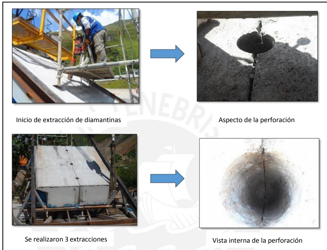
Figura 25. Extracción de diamantinas en los bloques de concreto
