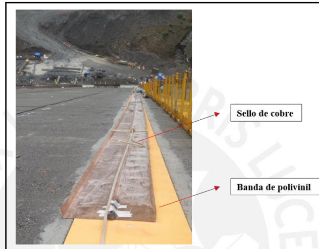
Figura 29. Banda de polivinil y sello de cobre
