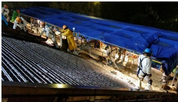
Figura 38. Vaciado durante lluvia
