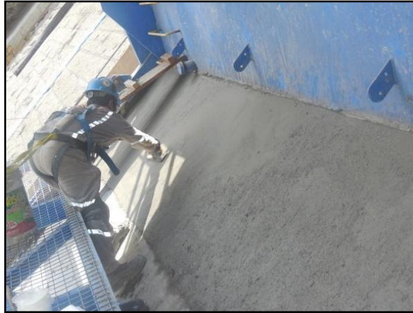
Figura 37. Solaqueo de losa
