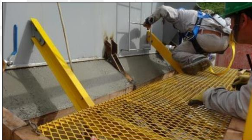
Figura 19. Aspecto del acabado y detalle de la cola de golondrina para el chaflán en el tope de la junta de inducción – Primera prueba
