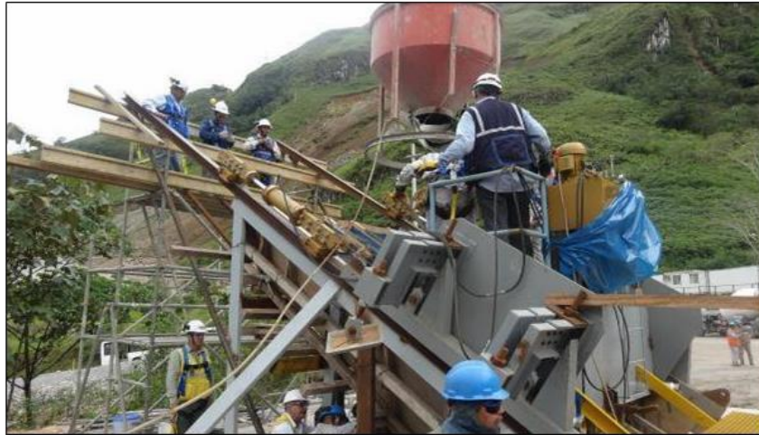
Figura 18. Concretado y desplazamiento de la regla – Primera prueba
