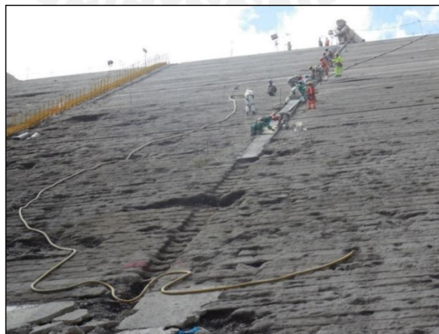
Figura 28. Colocación del mortero de asiento en la junta
