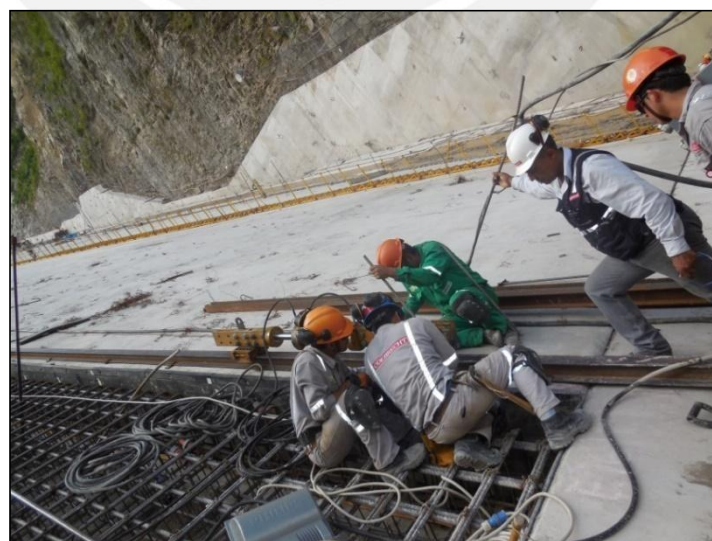
Figura 34. Ensamblaje de gatos hidráulicos
