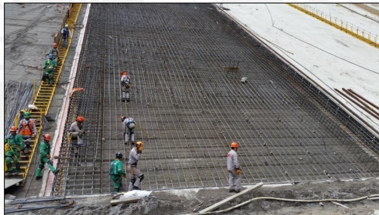
Figura 31. Armado de acero en la Losa 11 a
