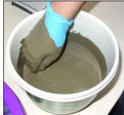
B.- Preparación del cemento
