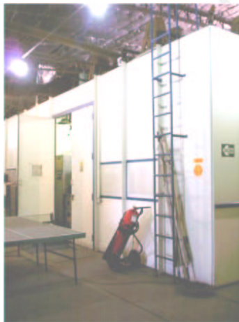
SALA DE TRANSMISION
