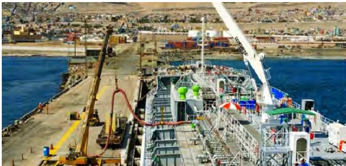
Figura 54. Muelle de SPCC en Ilo
