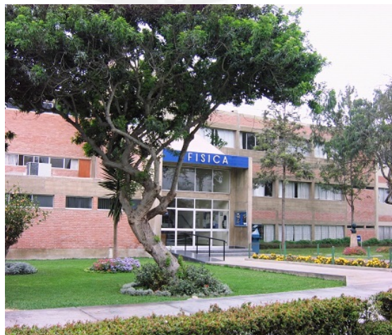
Figura 2.1: Edificio de Física de la PUCP
