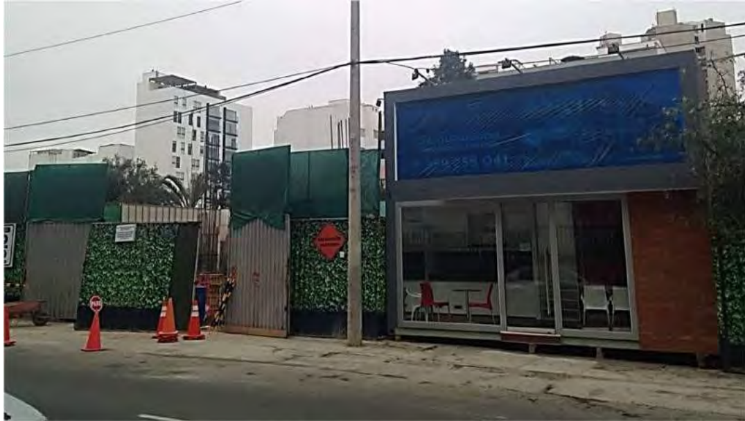
Figura 45: Avance de obra en edificio San Fernando a setiembre del 2018
