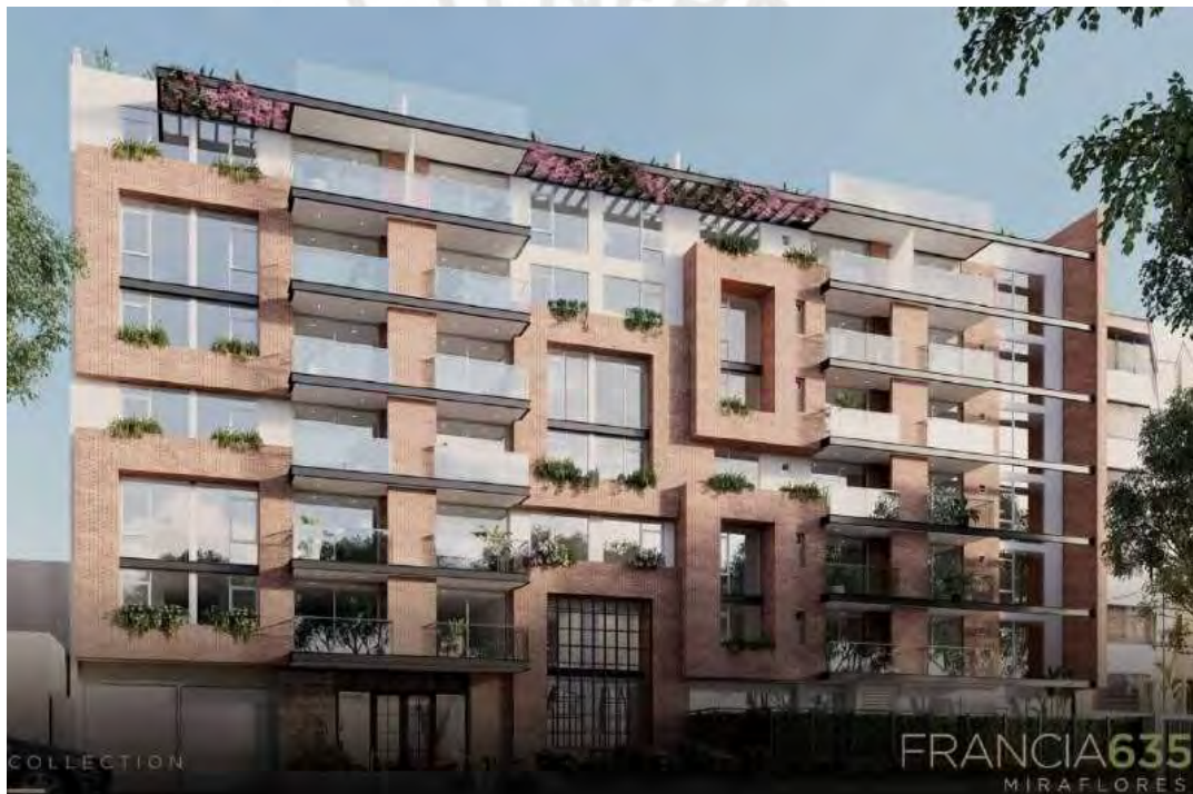
Figura 41: Fachada de edificio Francia de Desarrolladora
