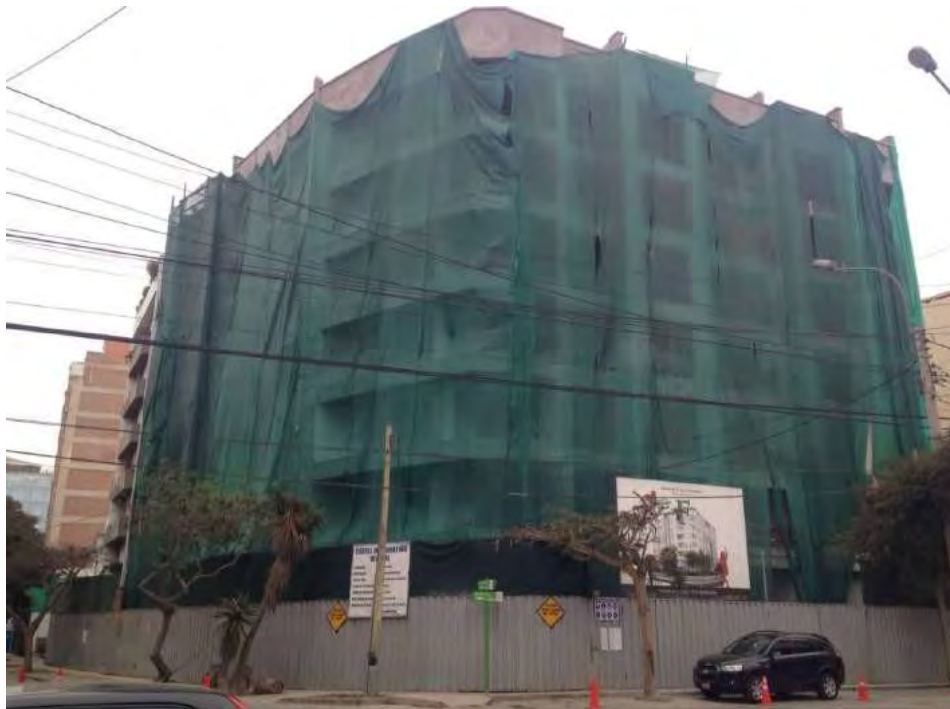
Figura 31: Fotografía del avance de obra a setiembre del 2018
