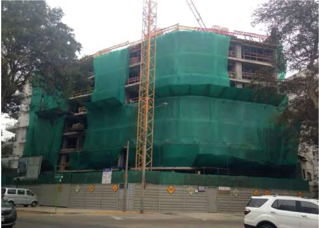
Figura 35 Avance de obra en edificio PAX a setiembre del 2018
