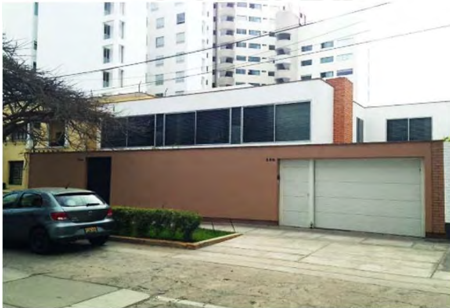
Figura 16: Fotografía de la casa ubicada en calle Las Acacias N°249-255
