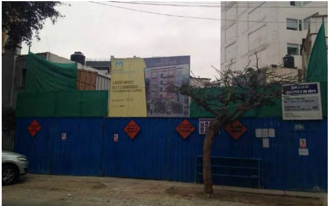
Figura 40: Avance de obra en edificio San Fernando a setiembre del 2018
