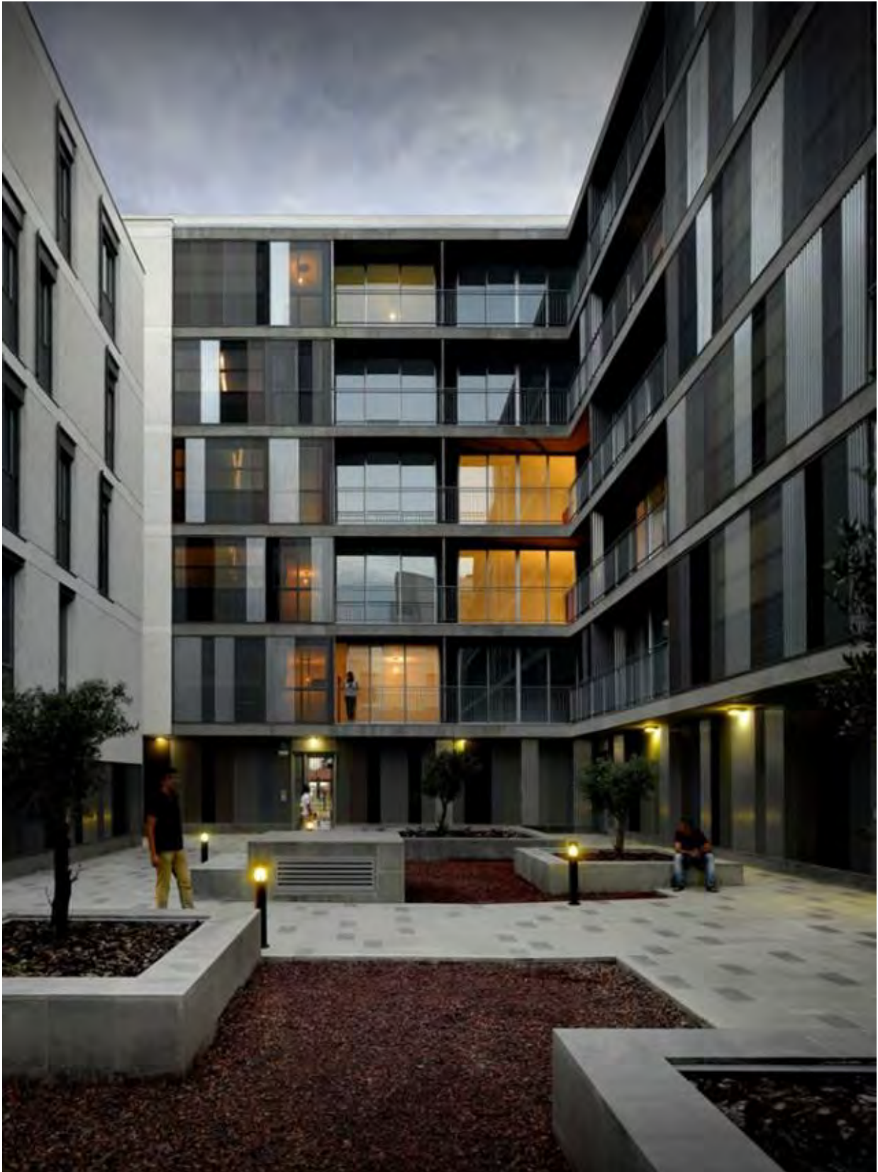
Vista referencial plaza central "Edificio el Bosque"
