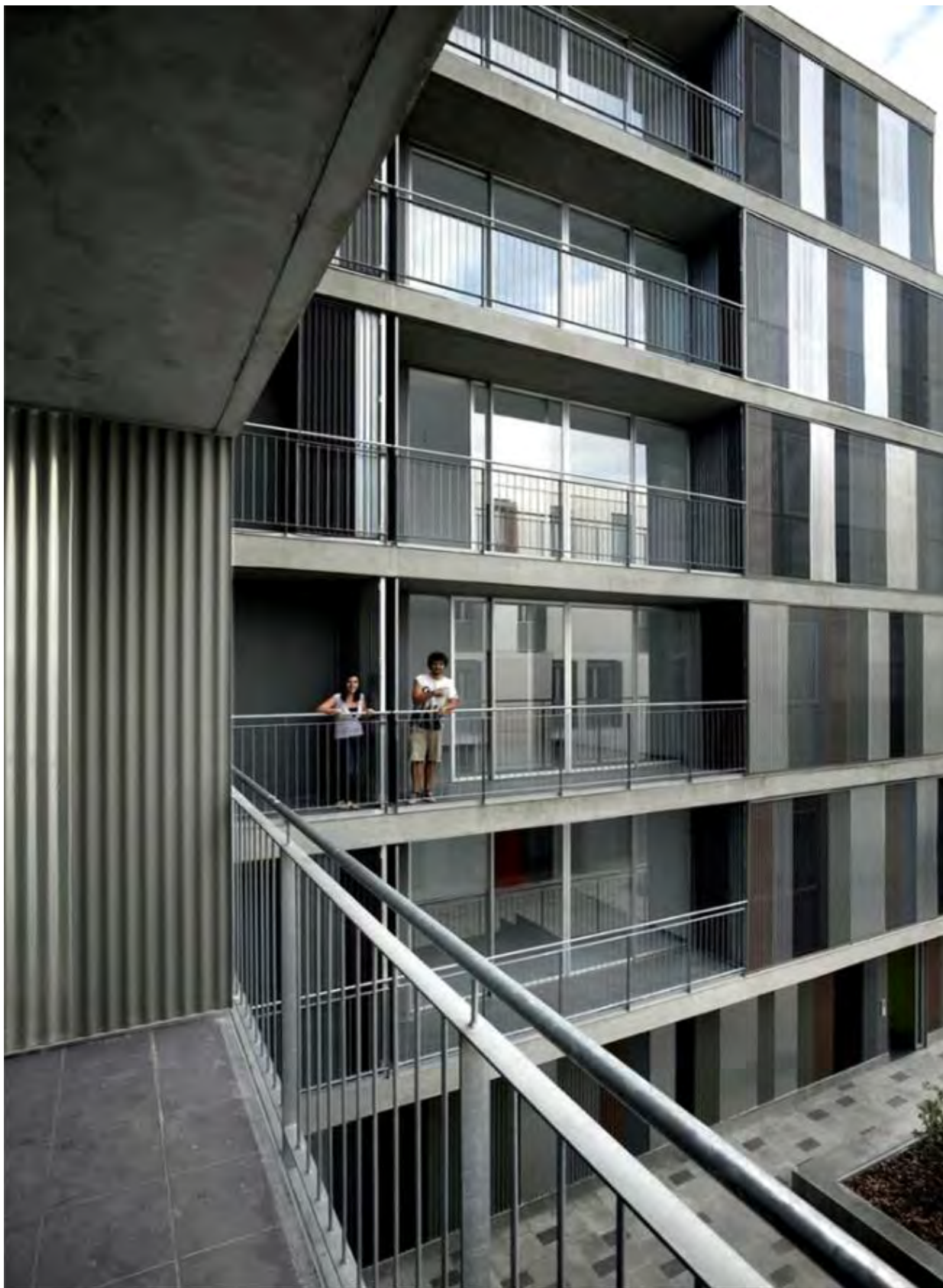
Vista referencial hacia la plaza central "Edificio el Bosque"
