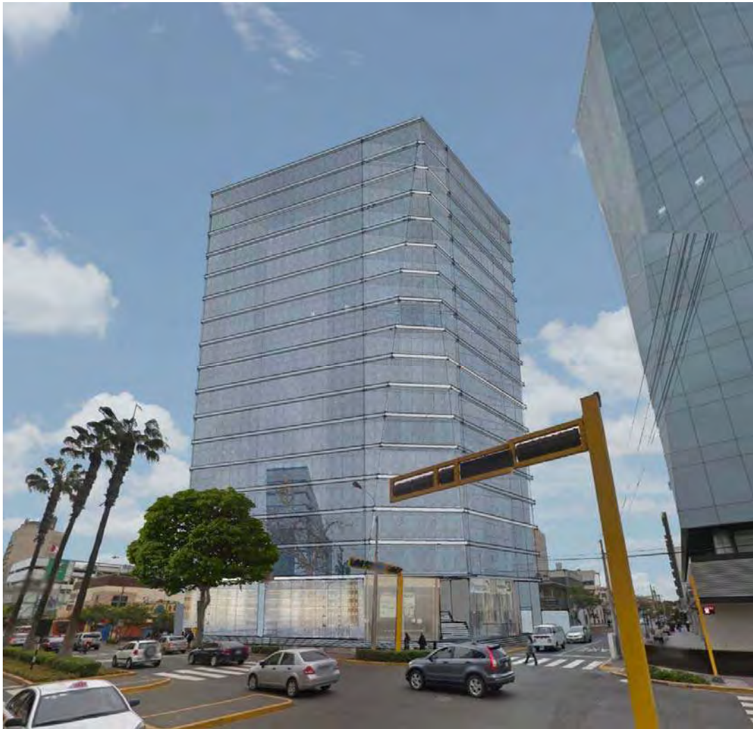
Imagen 19: Vista principal del edificio de Oficinas (referencial) Fuente: Elaboración propia
