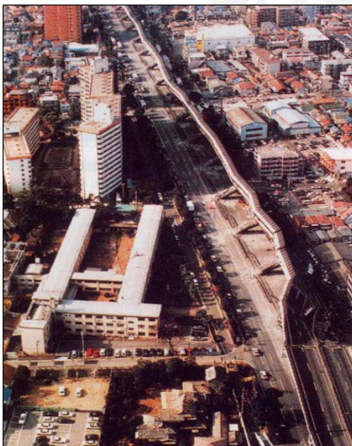
Figura 7.1.2 (n): Volcamiento de autopista elevada. Nótese que la autopista se soportaba en voladizo sobre columnas dispuestas en una fila. Terremoto Kobe 1995. (Kuroiwa, 2002)
