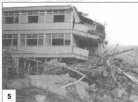
Figura 10.2.1 (e) Daños en edificios con pórticos de concreto y tabiques de albañilería. 1 Comportamiento. 2 Daños en tabiquería de edificio de departamentos, terremoto de Caracas 1967. 3 Diagrama de fuerzas sísmicas en función del nivel. 4 y 5 Terremoto Armenia - Quindío 1999, daños en tabiquería de Edificio Municipal y colapso de Estación de Policía. ( www.iitk.ac.in , Kuroiwa (2002) y www.eeri.org )
