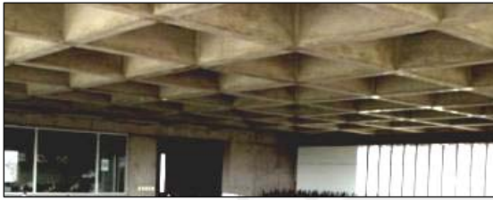
Figura 12.1.3 (b) Losas nervadas en dos direcciones (C. Huapaya)
