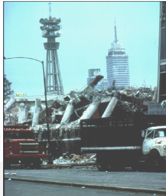
Figura 7.1.2 (h) Delante: Edificios totalmente colapsados Atrás: Torre Latinoamericana, sin daños ( www.scieds.com )
