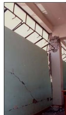
Falla por columna corta sin estribos C.E. Fermín del Castillo -T Terremoto Nazca 1996
