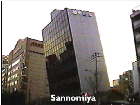
Figura 8.2 (f) Edificio inclinado en suelo con licuefacción. Kobe 1995. www.seismo.unr.edu
