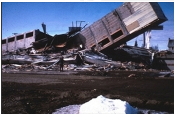
Figura 10.2.2 (c) Colapso por torsión en plantas aparentemente simétricas del edificio Four Seasons, terremoto Anchorage 1964. (www.dggs.dnr.state.ak.us y Arnold, 1987)
