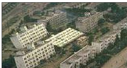
8.2 (e) Inclinación y volteo de los edificios de apartamentos en Kawagishico ( www.ce.washington.edu )
