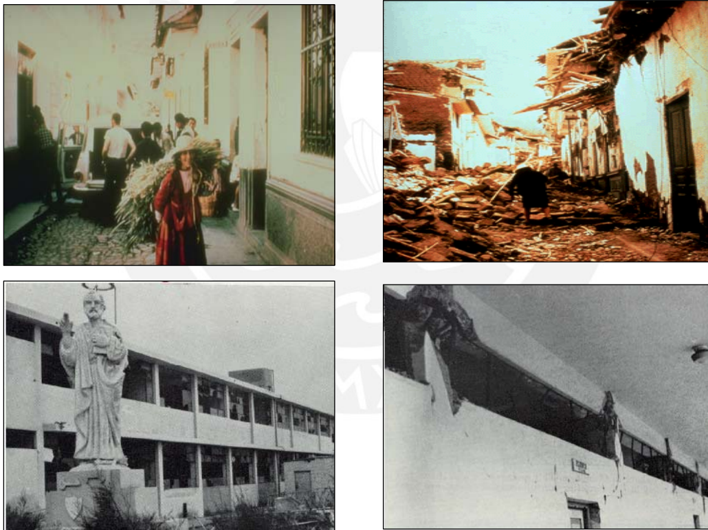
Figura 7.2.2 (b) Terremoto Ancash 1970: Arriba: Calle y viviendas típicas antes y después del terremoto - Huaraz Abajo: Colegio en Chimbote con falla de columnas cortas. (www.huaraz.org y D. Quiun)
