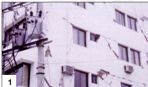
Figura 7.1.2 (r) Edificio Spondilus: Agrietamiento en la losa y desprendimiento de mampostería,
