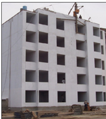
Figura 12.2.3 (b): Sistema estructural de muros resistentes en un edificio de viviendas ( www.pucp.edu.pe )
