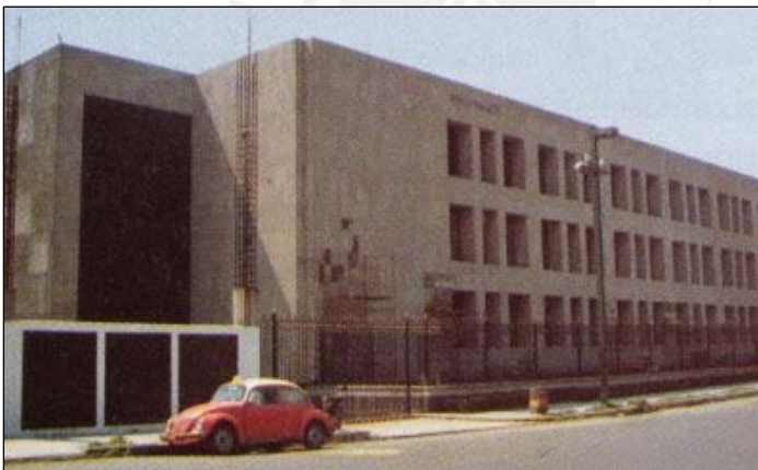
Figura 7.1.2 (i) Edificio bajo y rígido, respondió satisfactoriamente al terremoto 1985. (Kuroiwa, 2002)
