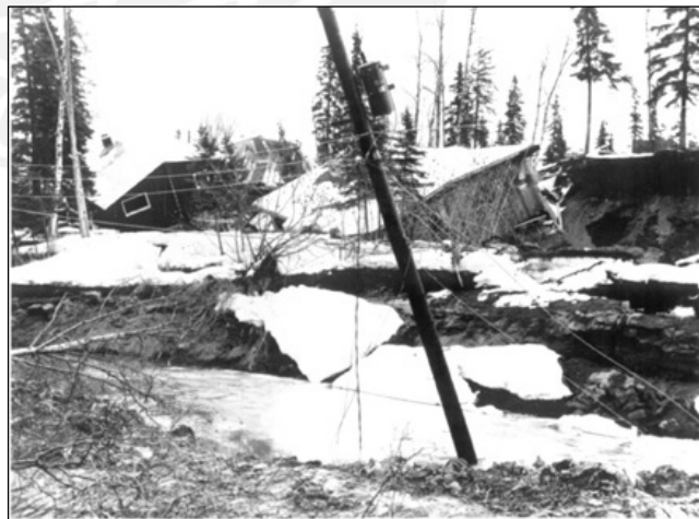
Figura 8.4 (b) Deslizamientos y depresiones del terreno – Turnagain Heights, causado por el terremoto de Anchorage 1964. ( www.showme.net )
