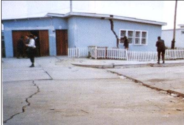
Figura 8.2 (j) Licuefacción de suelo en Chimbote, Terremoto 1970. (Kuroiwa 2002)
