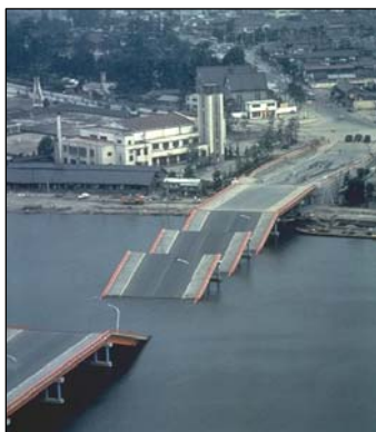
Figura 8.2 (c) Puente Showa – Niigata 1964. Colapsó por falla de pilares, recién terminado de construir. www.cee.uiuc.edu
