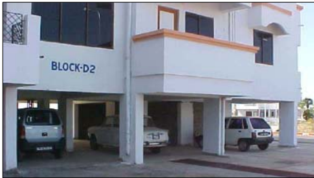
Figura 10.2.1 (b) Edificios con piso blando ( www.eeri.org y www.iitk.ac.in )
