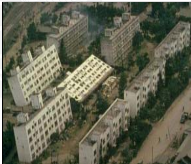
Figura 7.1.2 (e) Edificios de apartamentos, asentados e inclinados, por licuefacción del suelo, en Kawagishico ( www.nwcreation.net/wiki )
