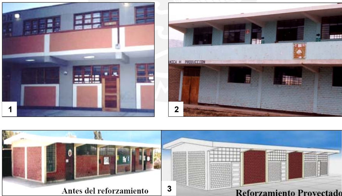
Figura 13.2.8 (b) Alternativas de solución para evitar columnas cortas (Quiun 2005)
