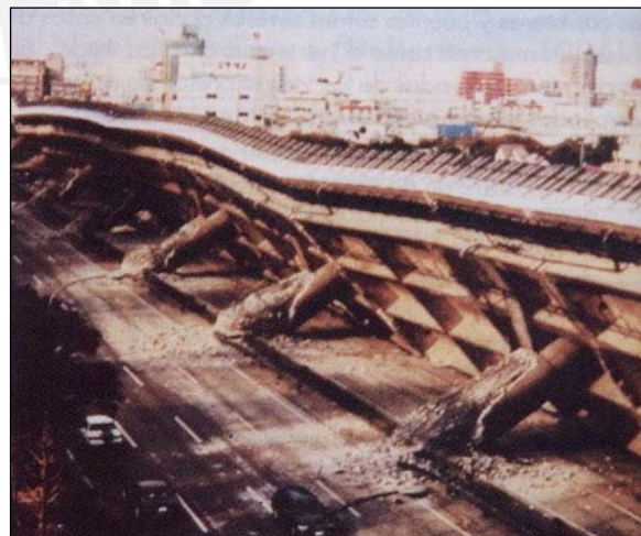
Figura 7.1.2 (n): Volcamiento de autopista elevada. Nótese que la autopista se soportaba en voladizo sobre columnas dispuestas en una fila. Terremoto Kobe 1995. (Kuroiwa, 2002)
