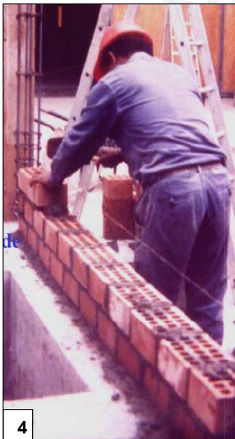
Figura 12.3.1 La albañilería de ladrillo confinada. 1. Elementos que conforman la albañilería confinada. 2. Ladrillos sólidos. 3. Dimensiones del ladrillo. 4. Albañilería asentada de sogá. 5. Albañilería asentada de cabeza. 6. Albañilería asentada con amarre americano. (San Bartolomé, 2002)
