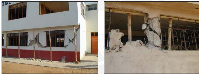
Figura 7.2.2 (h) Terremoto de Atico, 2001, efectos en Tacna. Falla de columna corta en una municipalidad distrital de Ciudad Nueva, Tacna (www.eeri.org)
