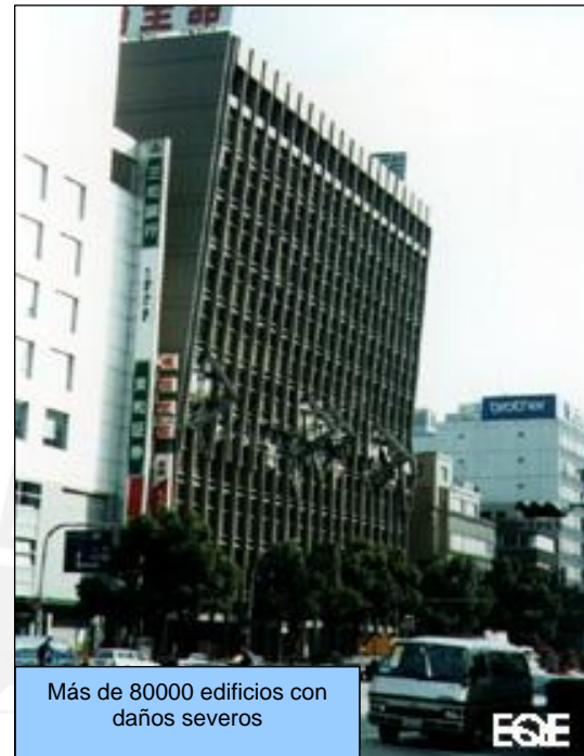
Figura 7.1.2 (l) Colapso de entrespacio a mitad de de altura ( www.hewett.norfolk.sch.uk )
