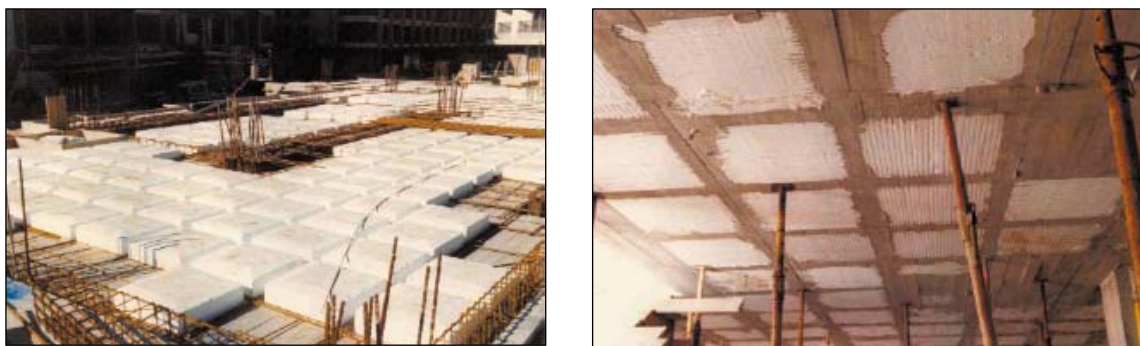
Figura 12.1.2 (b) Otra alternativa de losas aligeradas armadas en dos direcciones con elementos de relleno livianos de 0.60 x 0.60 m ( www.geosolmax.es )
