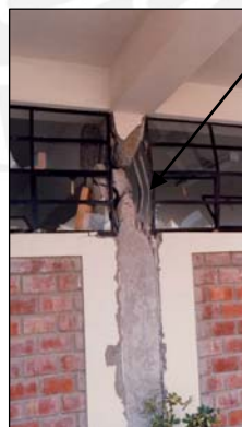
Falla por columna corta sin estribos C.E. Fermín del Castillo -T Terremoto Nazca 1996
