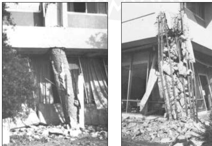
Figura 9.1.2 (f) Columnas con comportamientos dúctil (izquierda) y frágil (derecha), en un pabellón del Hospital Olive View, terremoto de San Fernando – California 1971.
