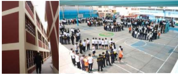
Rutas de evacuación inapropiadas, criterios de diseño sismorresistente obsoletos y niveles aceptables de conocimiento de riesgos en algunos colegios
