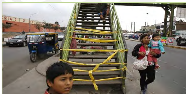
Figura 17 Vecinos de comas cierran puente peatonal tras accidente. Fuente: Perú 21, 2014.
