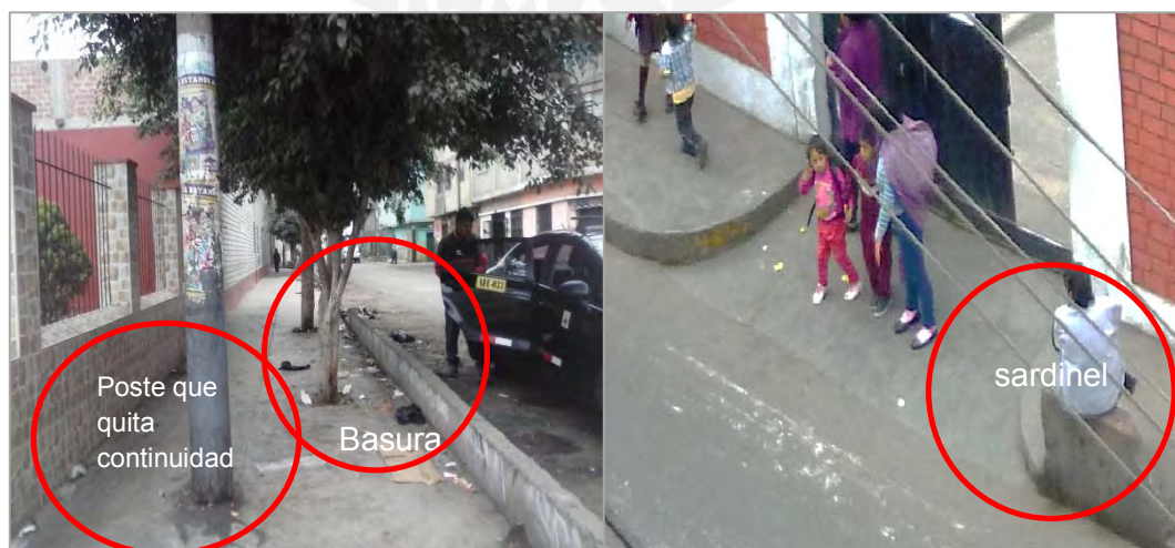
Figura 63 Principales problemas en la colocación de elementos urbanos. Izquierda: Av. Oilanta. Derecha: puerta del CE Señor de los Milagros. Fuente: propia.
