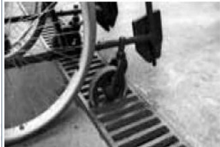
Figura 40 Rueda atascada en rejilla mal colocada. Fuente: Municipio de Santiago, 2010.
