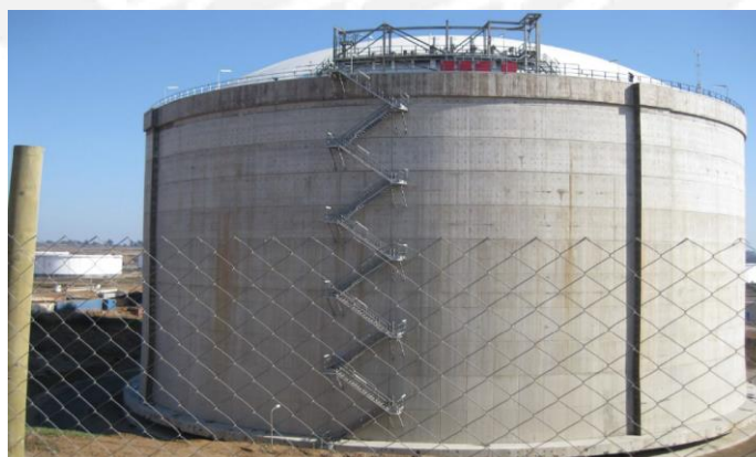
Figura 1.8 Tanque para almacenamiento de gas natural líquido con base aislada después del terremoto de Maule 2010 de Magnitud 8.8.
