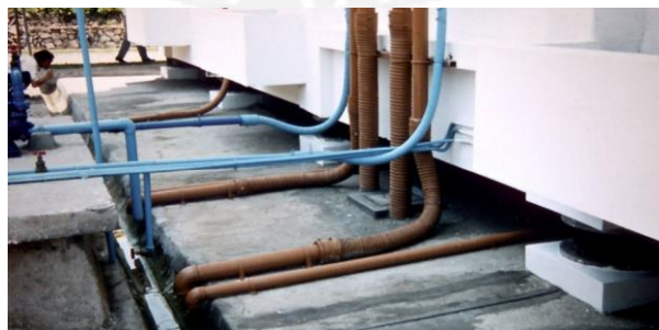
Figura 1.5 Conexiones flexibles para los servicios públicos.
