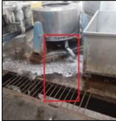
Figura 24: Centrifuga industrial Fuente: La Empresa
