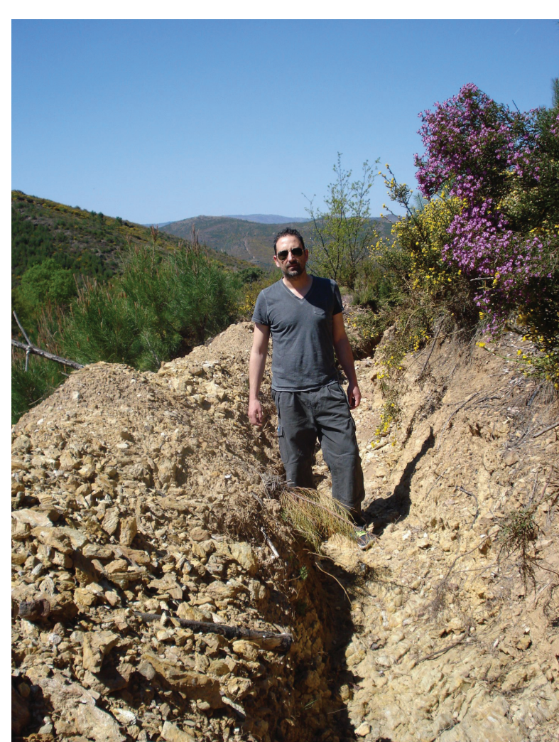
Fot. 1 - Aspeto do canal retangular (Foto tomada a 10 de abril de 2017).
