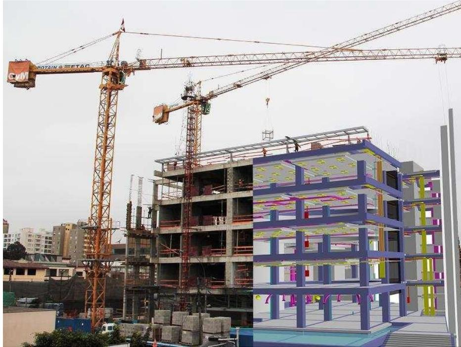
Figura 228 Representación virtual tridimensional mediante el uso del BIM (Proyecto: Universidad del Pacífico) (fuente: Google imágenes)
