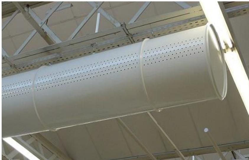
*Figura 132 Conductos metálicos microperforados con cavado pintado (fuente: Klimagiel)*
