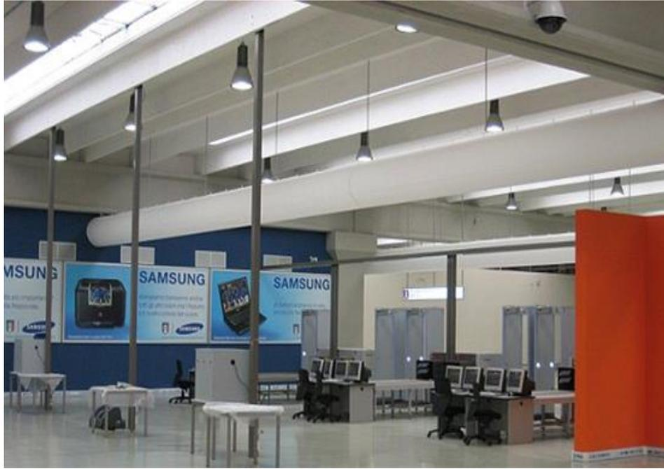
*Figura 115 Aplicación de conductos textiles (fuente: Klimagiel).*
