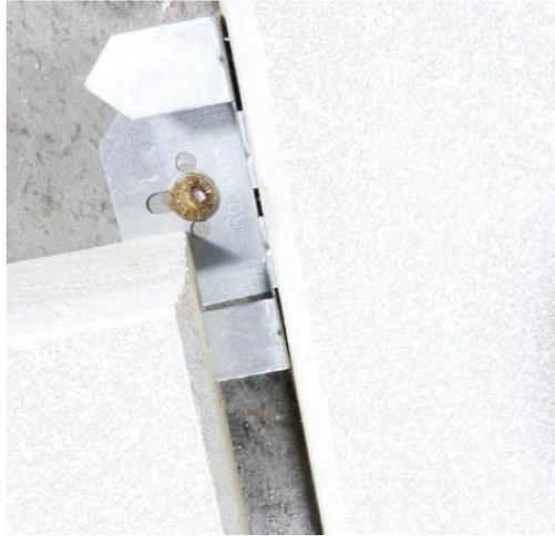
Figura 68 Proceso de colocación de un panel tipo Facett de Rockfon. El enganche es oculto mediante ensamble que se fija directamente a la cara inferior del forjado. (fuente: rockfon.es)
