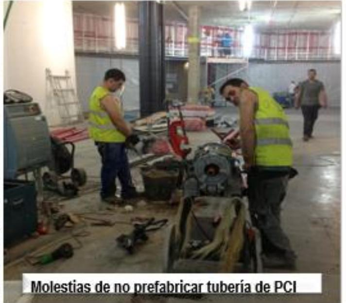
**Molestias de no prefabricar tubería de PCI**
