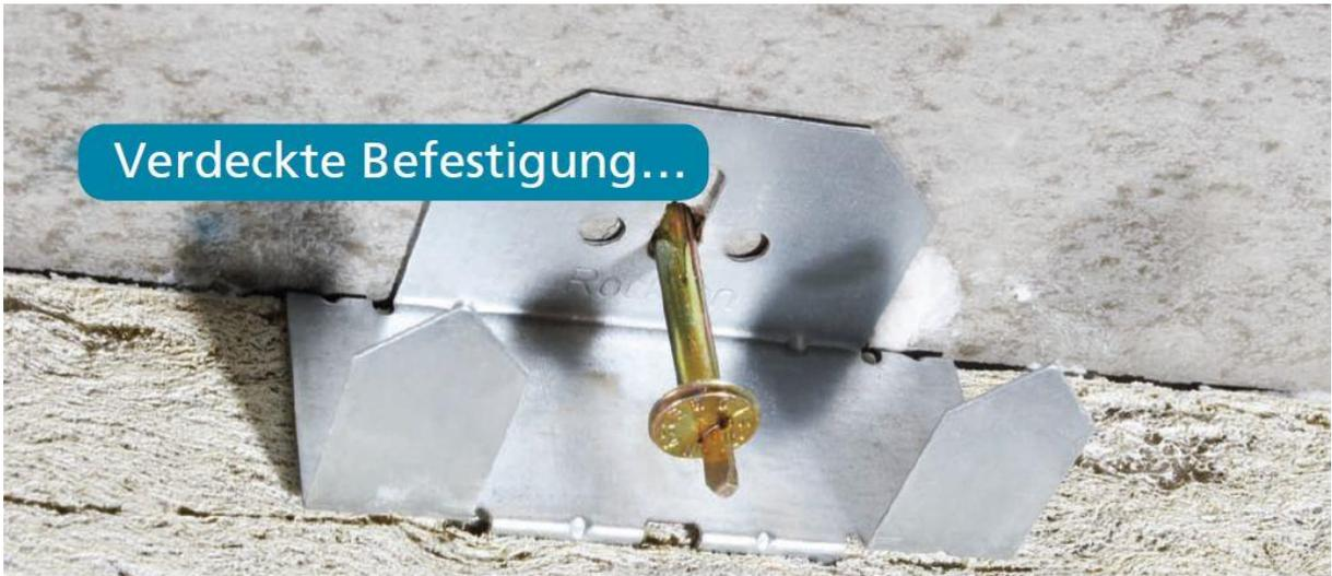
Figura 71 Detalle de la fijación del sistema Facett. Las pletinas de acero galvanizado quedan introducidas y ocultas en el panel. . (fuente: rockfon.es)
