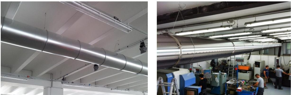
Figura 142 Conductos realizados con sistemas de fijación de Gripple (fuente: Gripple).
