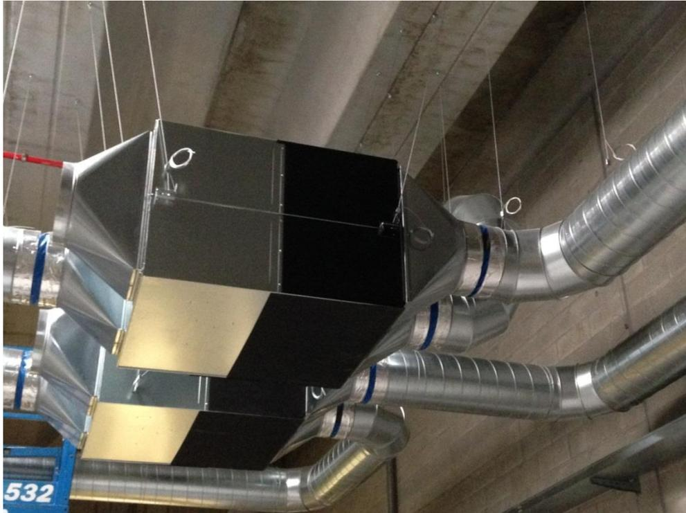
*Figura 148 Soporte en suspensión tipo Gripple para equipos de climatización (Fuente:Gripple).*
