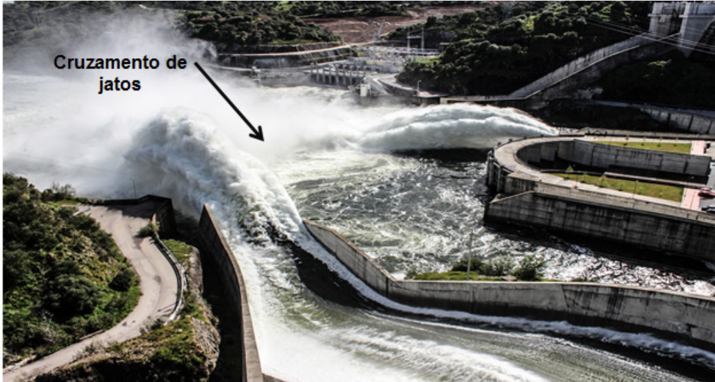
Figura 2.6 – Barragem do Alqueva, sistema de dissipação por jatos cruzados (Machado, 2016).
